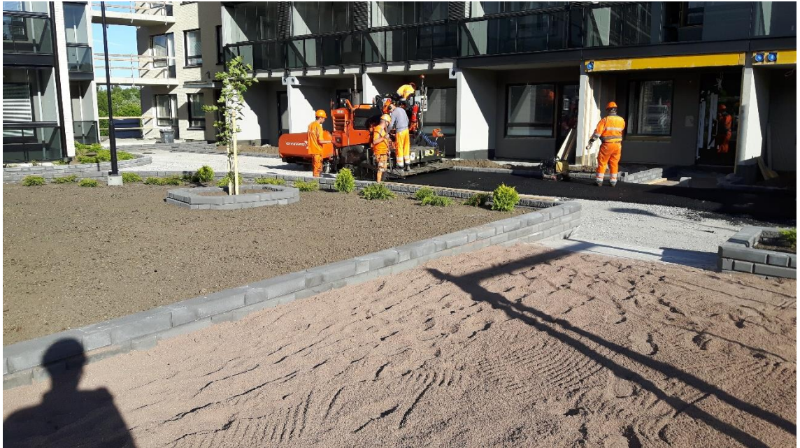
Kuva 8. Ahtailla pihoilla kannattaa käyttää pientä asfalttikonetta.
