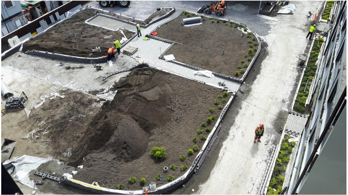
Kuva 6. Muurikivien, pihalaatoituksen ja nurmikon asennus.
