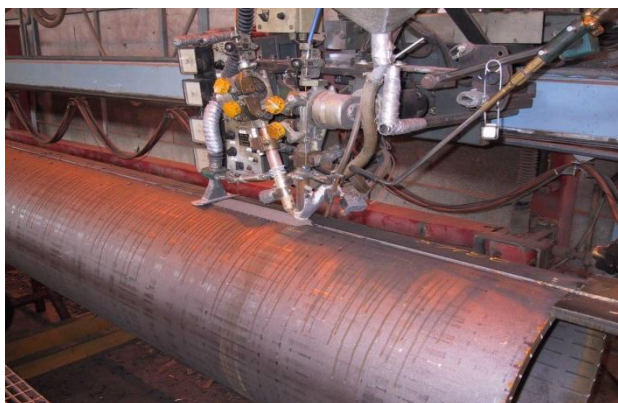
Kuva 16. Pituussauman ulkopuolinen hitsaus, kahdella langalla (Presteel Oy 2017)
