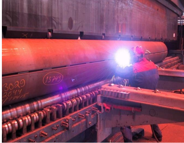
Kuva 14. Telaputkiaihio silloitushitsauksessa (Presteel Oy 2017)
