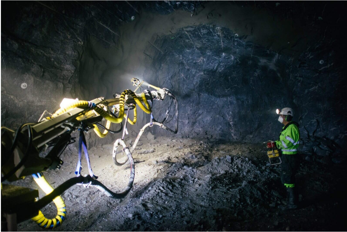
KUVA 3. Betonin ruiskutusta tunnelissa (Normet for Tough Jobs. 2016)
