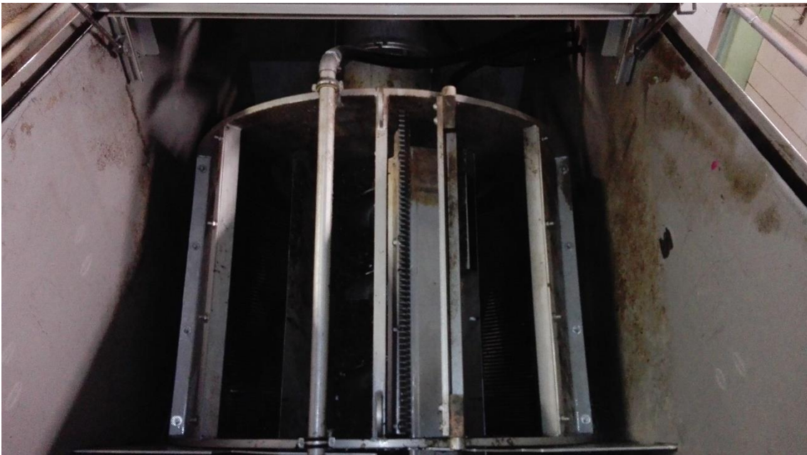
KUVA 2 Ruskon biokaasulaitoksen välppäseula
