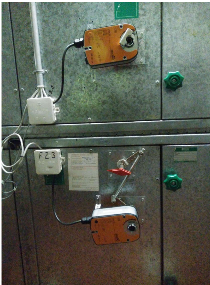
Kuva 14: Peltimoottorit asennettuina (Jesse Miettinen 2016-9-8)
