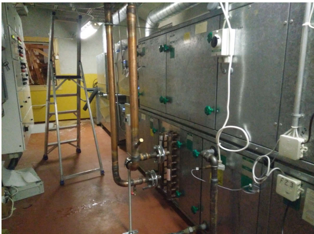
Kuva 10: Ilmanvaihtokone saneerausvaiheessa (Jesse Miettinen 2016-9-8)
