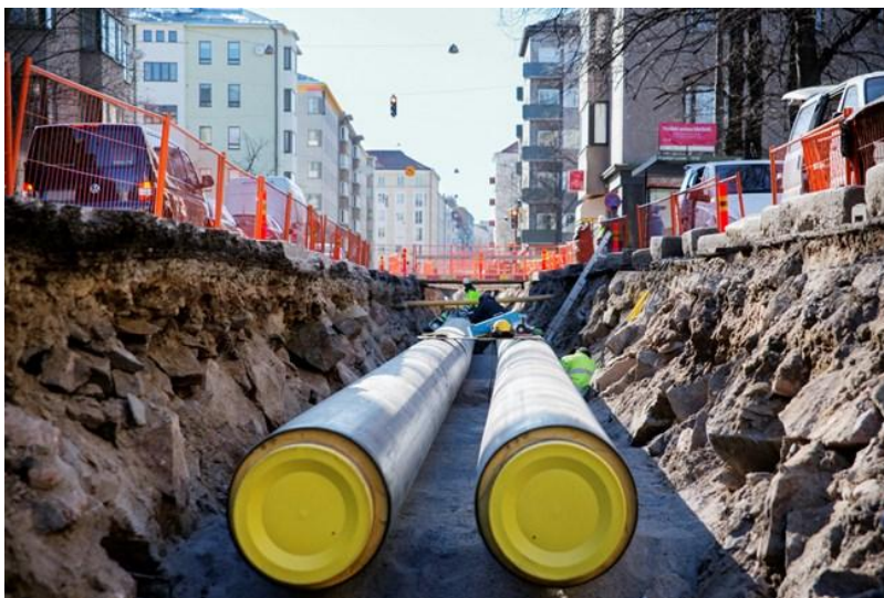
Kuva 11. Kaukojäähdytyksen jakeluun käytettävät kiinnivaahdotetut putkielementit (Aaltonen 2015).
