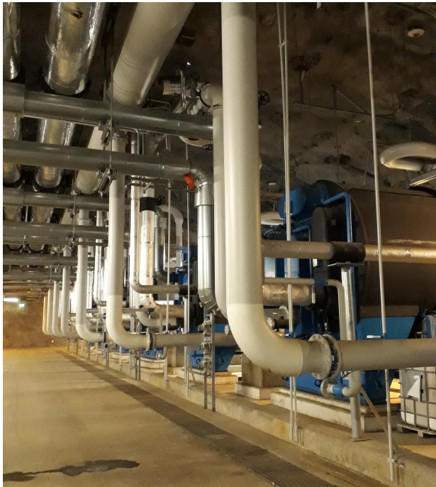
Kuva 5. Salmisaaren hiilluolan absorptiojäähdytyskoneet.
