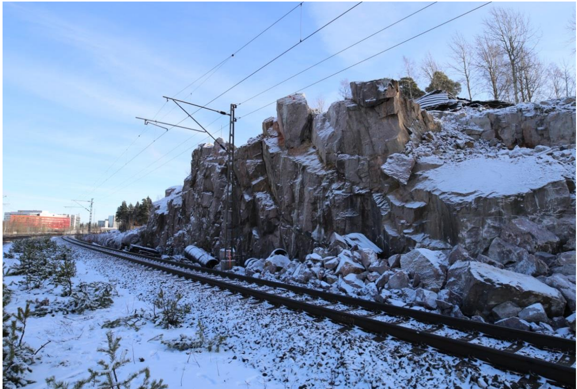
Kuva 6.[13]. Louhittava kallioseinä ja sen välittömässä läheisyydessä oleva itäisen raitteen ajojohtimien kannatinpylväs.
