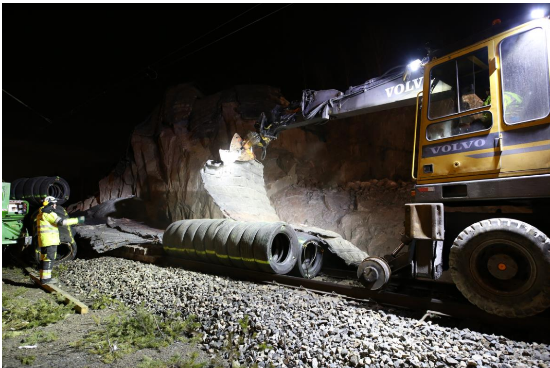
Kuva 8 Ratasuojauksen rakentamista kiskopyöräkaivinkoneella.
