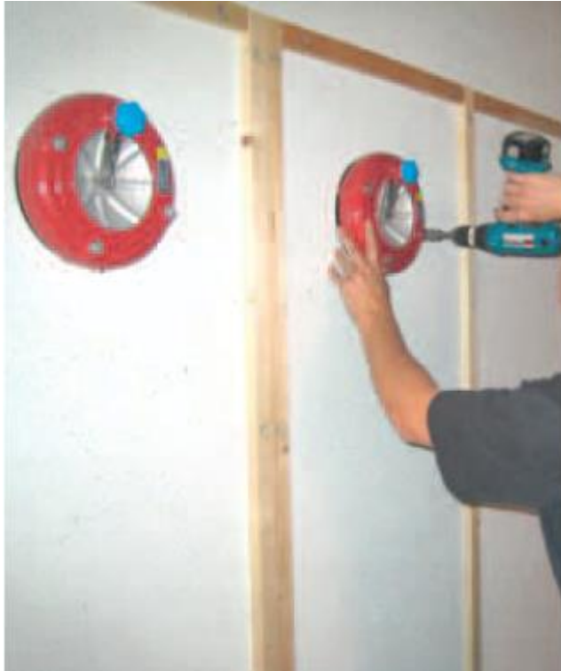
Kuva 8. Ylipaineventtiilin YV-1 asentaminen läpivientiputkeen LP-1 [4, s. 8.]
