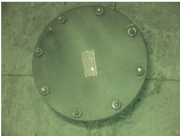
Kuva 10. Normaaliolojen ilmanvaihdon sulkulaite asennettuna paikalleen (kuva Suomen Pelastusalan Keskusjärjestö (SPEK), väestönsuojatarkastajan koulutusmateriaali)
