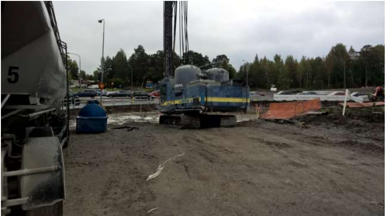
KUVA 7 Maaperän pilaristabilointia Betoroc-mursketäytön päällä
