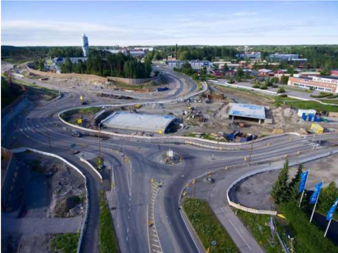
KUVA 8 Väliaikainen kiertoliittymä ja valmistuvat sillat (9.)
