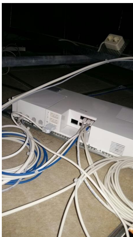
Kuva 18. Esyluxin ohjausyksikkö
