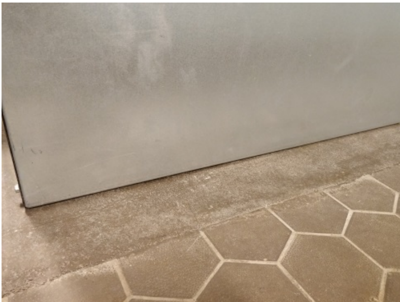
KUVA 6. Äänieristyskuoren ja lattian väliin lisättiin tiiviste.
