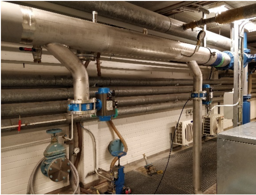
KUVA 8. Uusi runkoputken osa.
