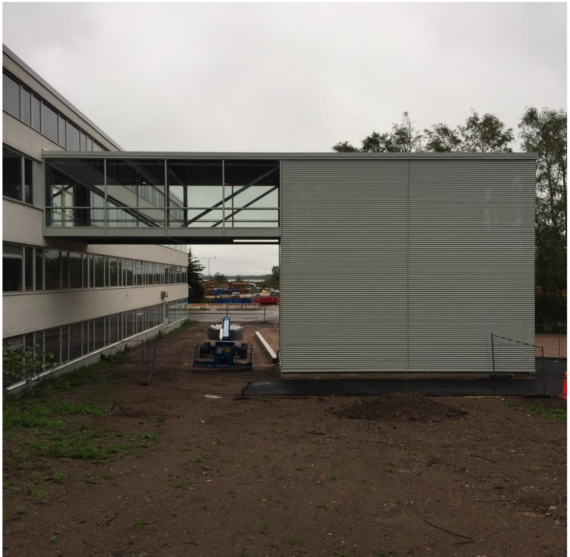
KUVA 10 Porrashuone ja kulkusilta valmiina, Niko Karjalainen, 2016
