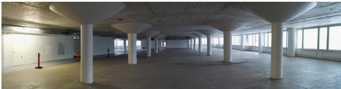
KUVA 4 Tilanne purkutöiden jälkeen, Oy Rakennuspartio, 2016
