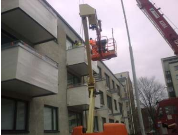
Kuva 8. Parvekkeiden nostotyö ja väliaikaiskiinnitys käynnissä
