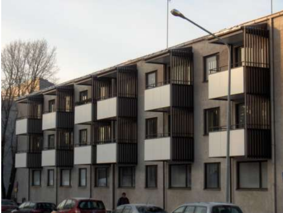
Kuva 9. Papinkatu 2 parvekkeiden asennuksen jälkeen
