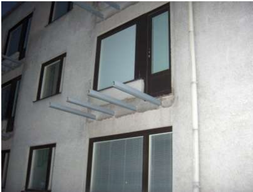
Kuva 7. Ruostesuojaukset ja paikkaustyöt valmiit
