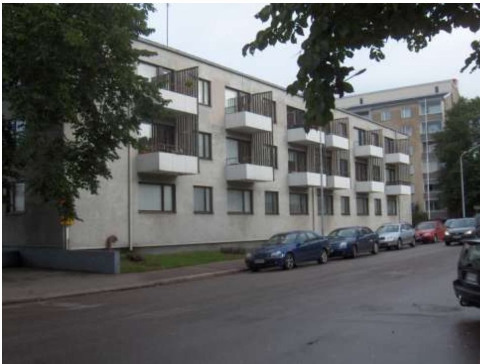
Kuva 2. Papinkatu 2 ennen korjausta
