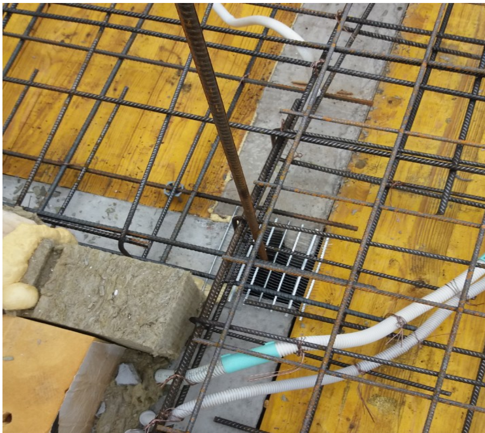
Kuva 13. Valuverkko seinäelementtien pystysauman päällä.
