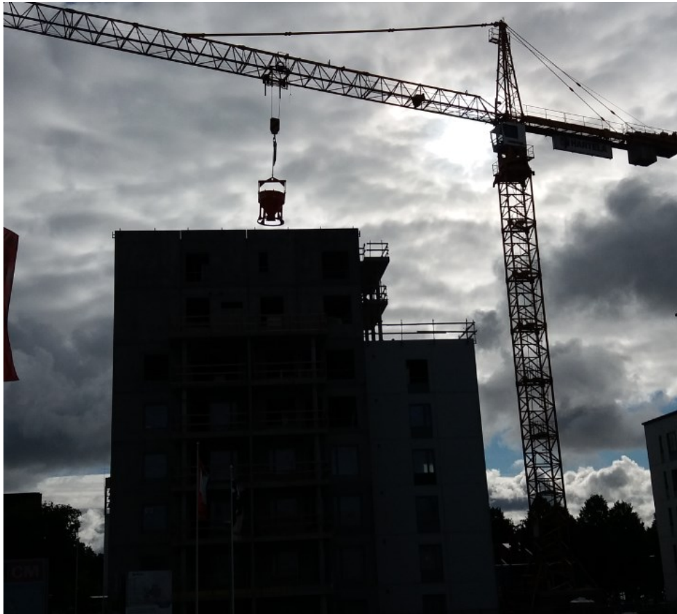
Kuva 2. Yläpohjan betonointi nostoastiavaluna.
