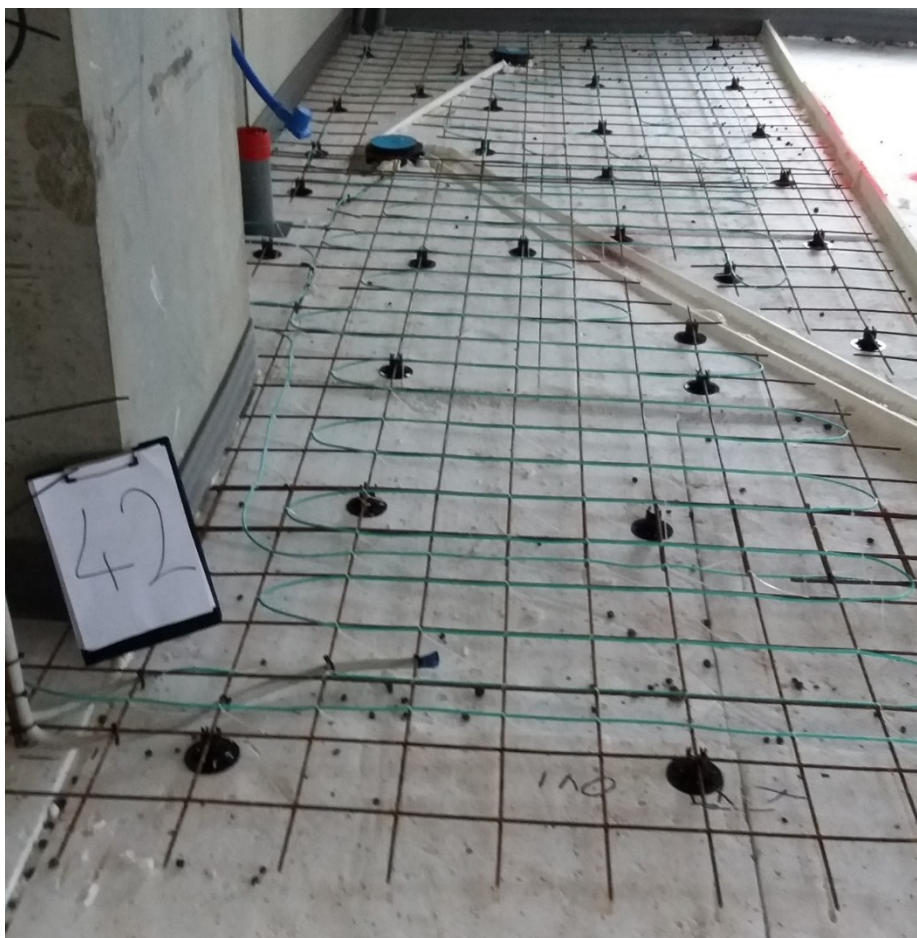
Kuva 21. Asuntokohtaisesti pesuhuoneesta otettu valokuva ennen valua.
