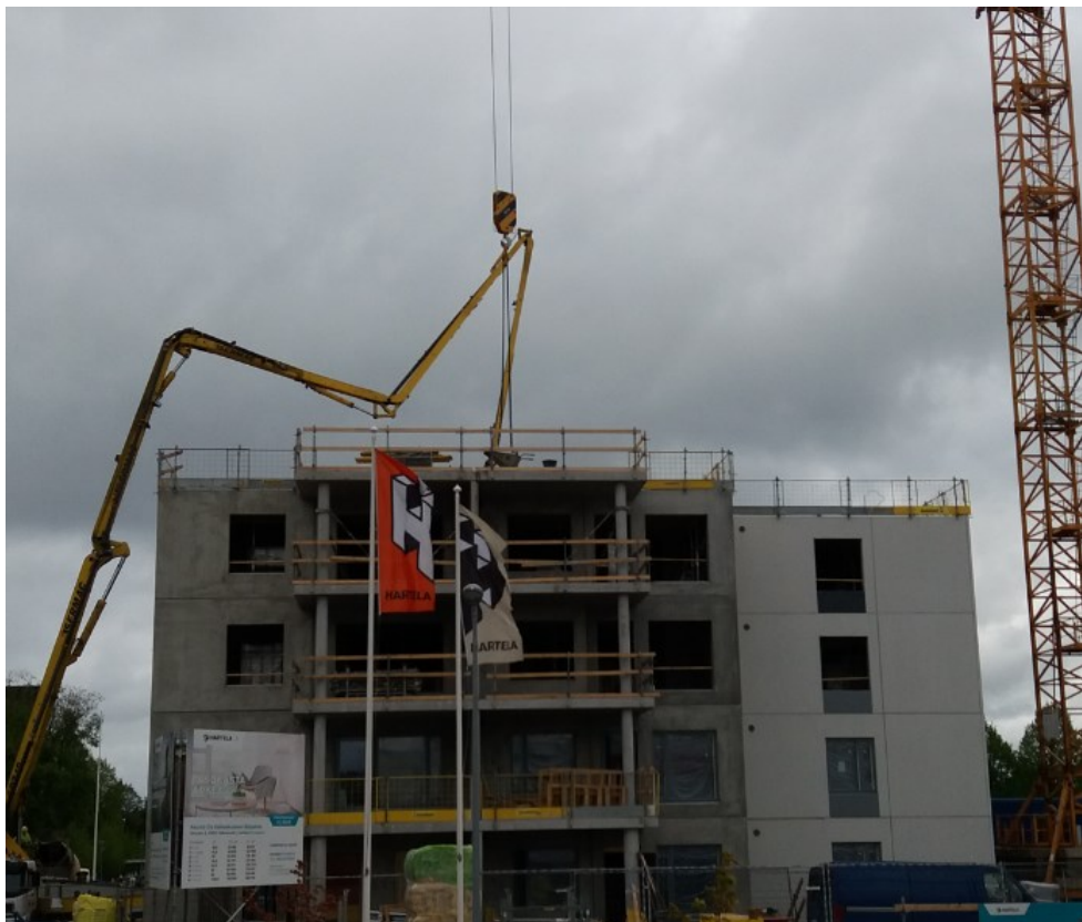
Kuva 1. Välipohjaholvin betonointi betonipumppuautolla.
