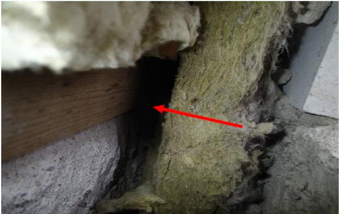
Kuva 7. Alaohjauspuun ja tuulensuojalevyn välissä oleva ilmarako
