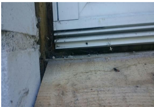
Lämpökuvauskohta 1. saunan ikkuna
