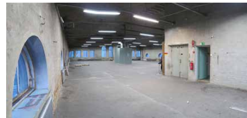
Kuva 4: Redi Living Lab ennen saneerausta. Kuva: SRV
