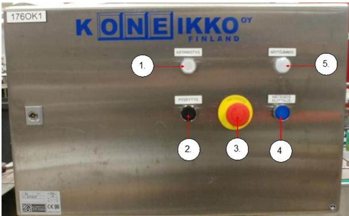
KUVA 20. Ohjauskaapin käyttöliittymä, jonka päätoiminnot ovat 1. käynnistyspainike/kone käy merkkivalo, 2. pysäytyspainike, 3. hätäseispainike, 4. häiriön kuitauspainike/häiriö merkkivalo ja 5. käyttöjännitteen merkkivalo
