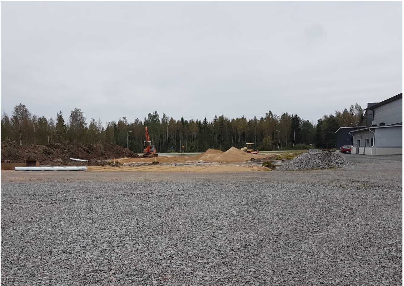
Kuva 2. Rakennuksen pohjatyöt (RKL Heikkinen OY 2017)
