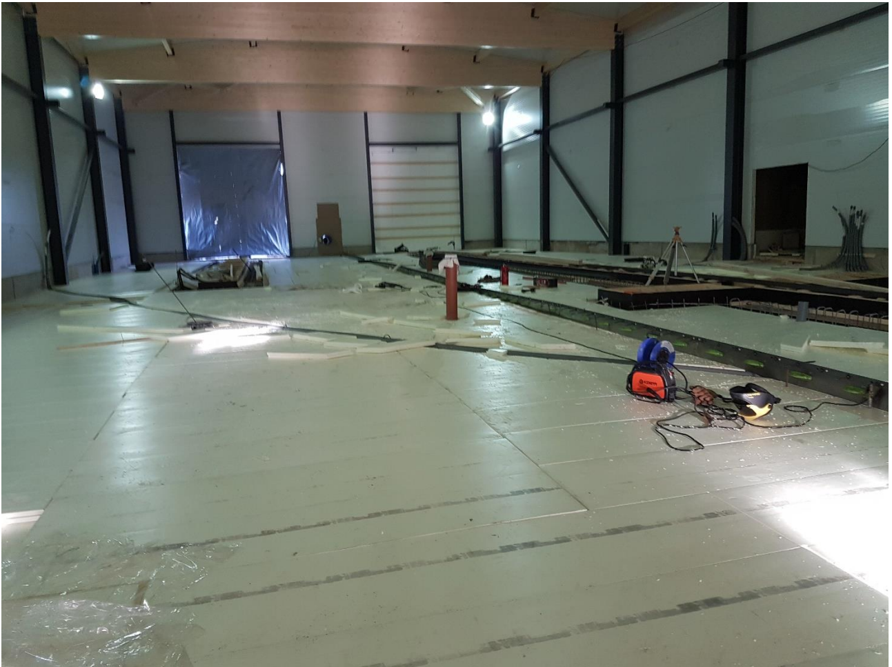
Kuva 8. Liikuntasauma ja eristeiden asennus (RKL Heikkinen OY 2017.)
