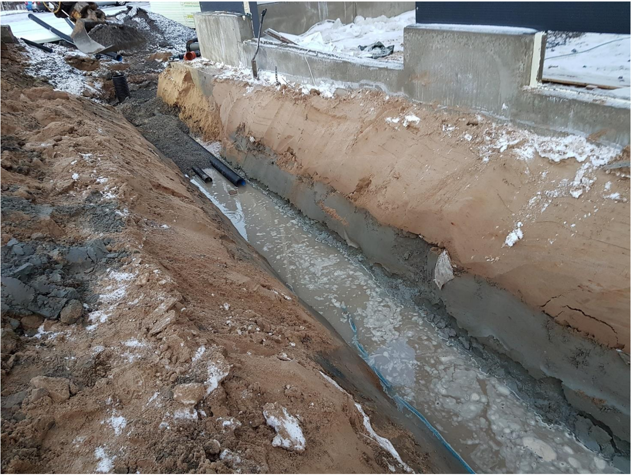
Kuva 3. Salaoja ja hulevesijärjestelmä (RKL Heikkinen OY 2017)
