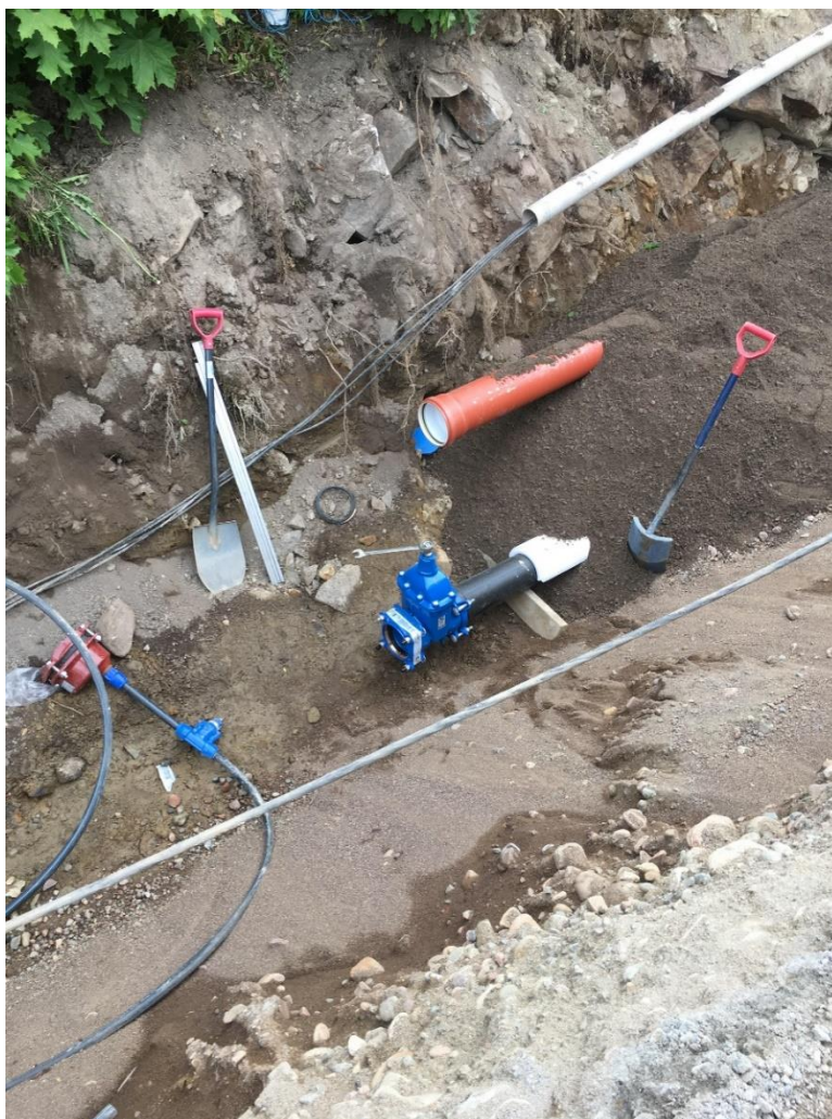
KUVA 4. Vesijohdon ja huleveden sijoittaminen samaan kaivantoon (Vauhkonen 2017-07-14).
