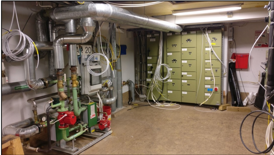
Kuva 21. Työvaihekuva, jossa odotellaan kesän tuloa.
