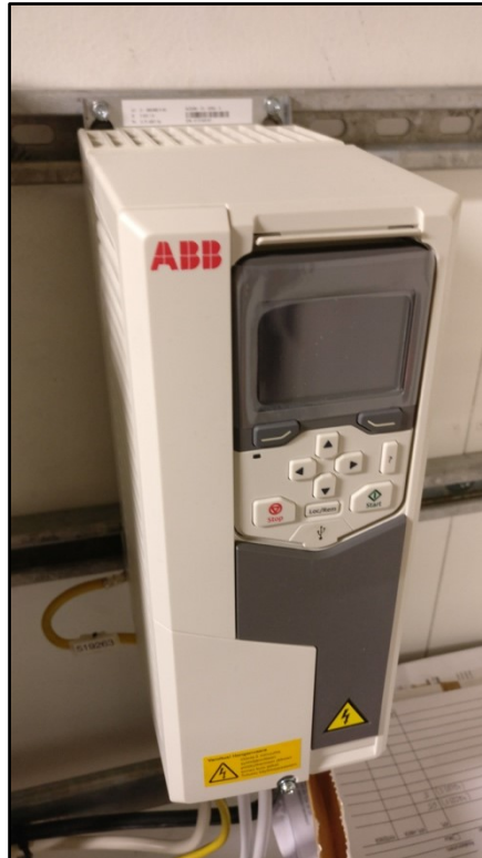
Kuva 20. ABB valmistamat ACS580-01-12A7-4 taajuusmuuttajat tulevat ohjaamaan uusia moottorilähtöjä.
