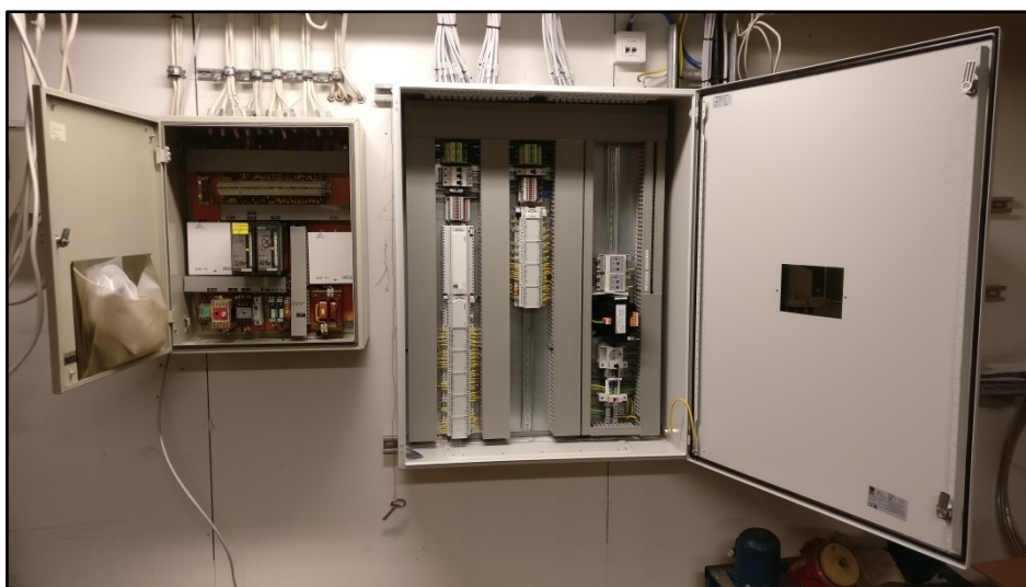
Kuva 19. Vanhan säätölaitekeskuksen rinnalle on rakenteilla VAK-38.
