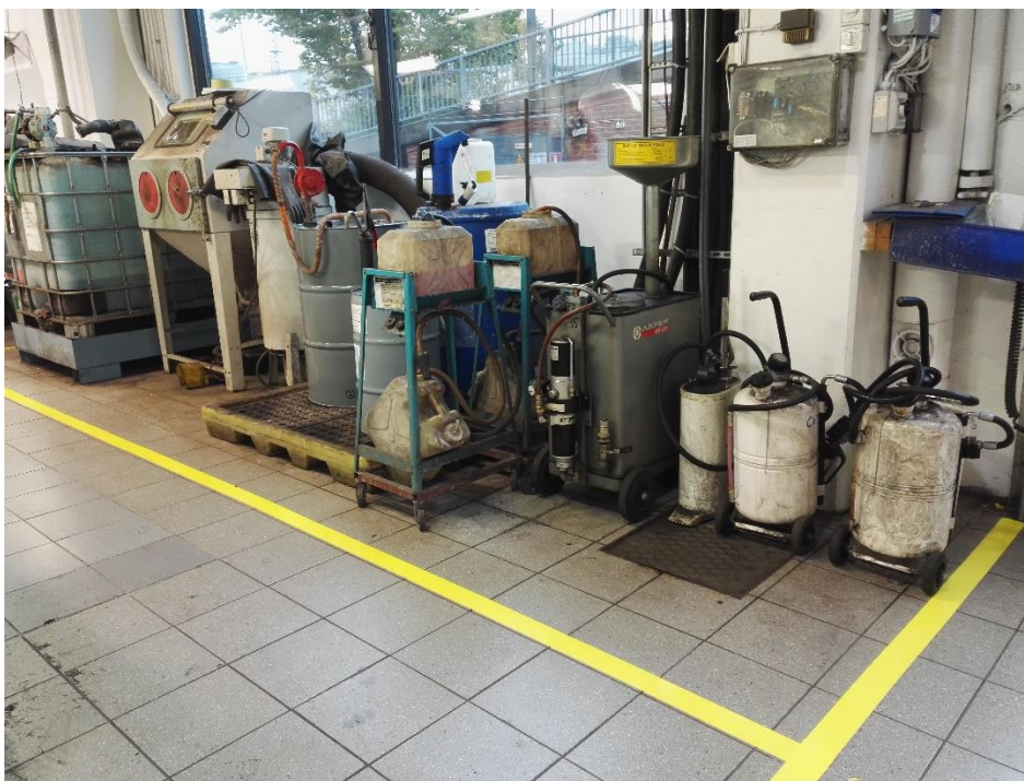
Kuva 25. Hiekkapuhalluslaitteen seinusta korjaamolaitteineen järjestelyn jälkeen.
