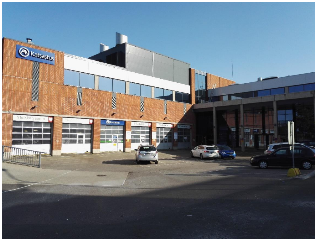
Kuva 10. Liikkeen takaosa ja huollonvastaanotto.
