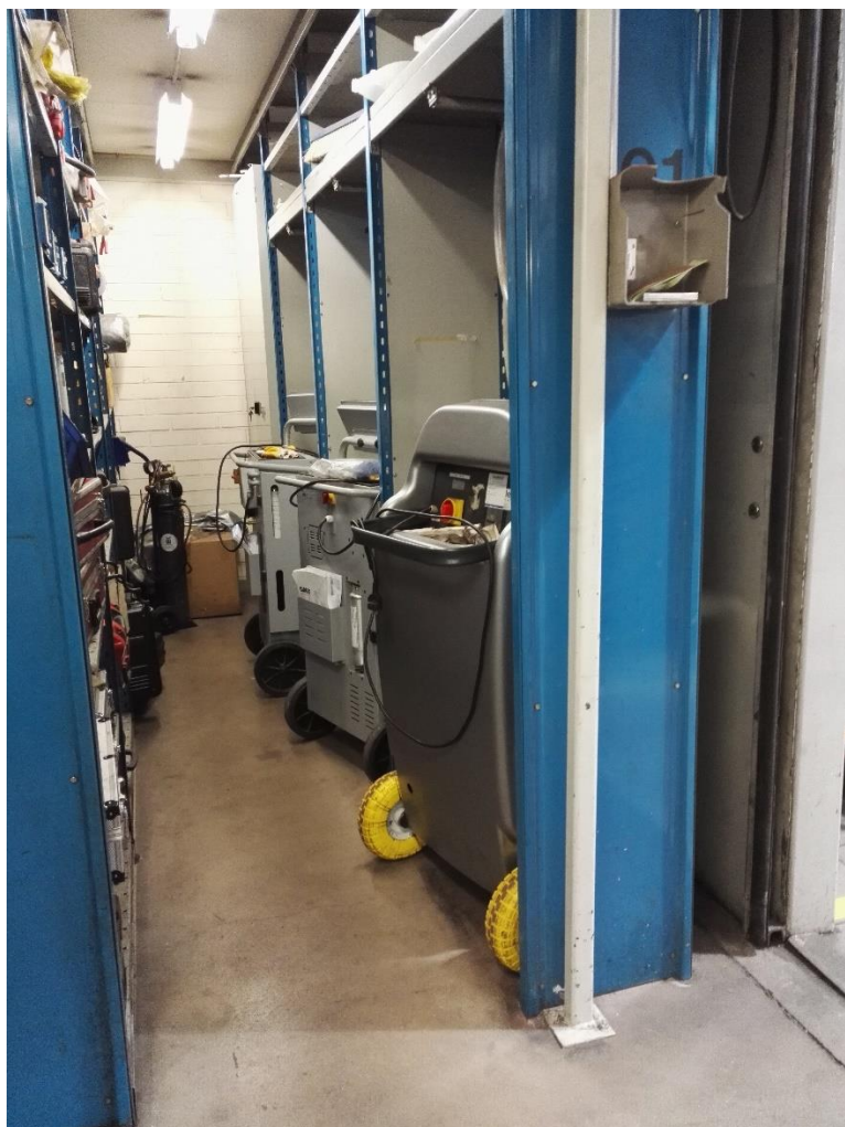
Kuva 22. Ilmastointilaitteiden vanha sijainti.
