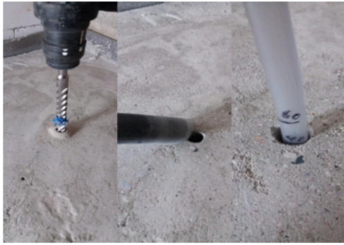
Porareian poraus ja huolellinen puhdistaminen (kohdat 6 & 7)
