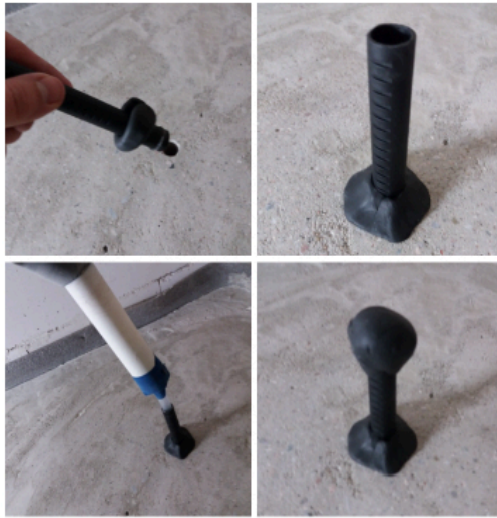
Mittausreiän tiivistys asennusputkella ja höyrytiivillä kitillä (kohta 8)
