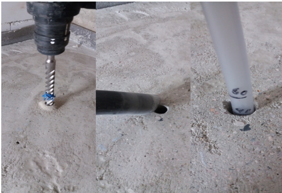
KUVA 3. Porareian poraus ja huolellinen imurointi
