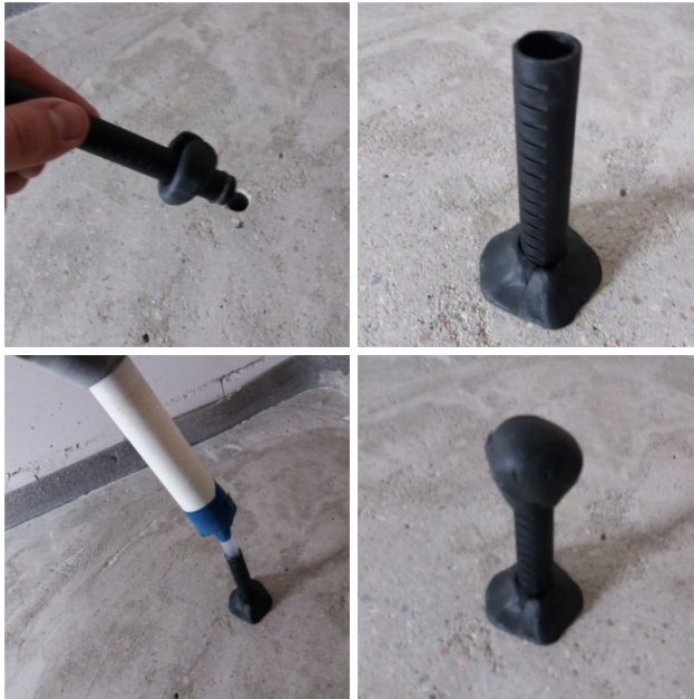
KUVA 4. Mittausreiän tiivistys asennusputkella ja höyrytiivillä kitillä
