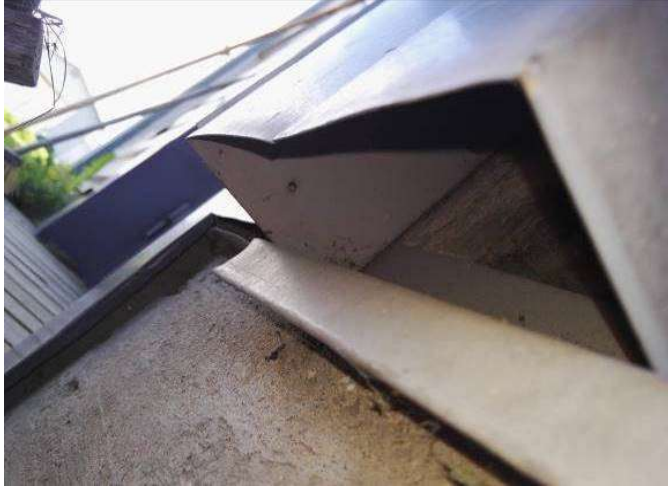
KUVA 12. Julkisivukotelo on auki alaosastaan
