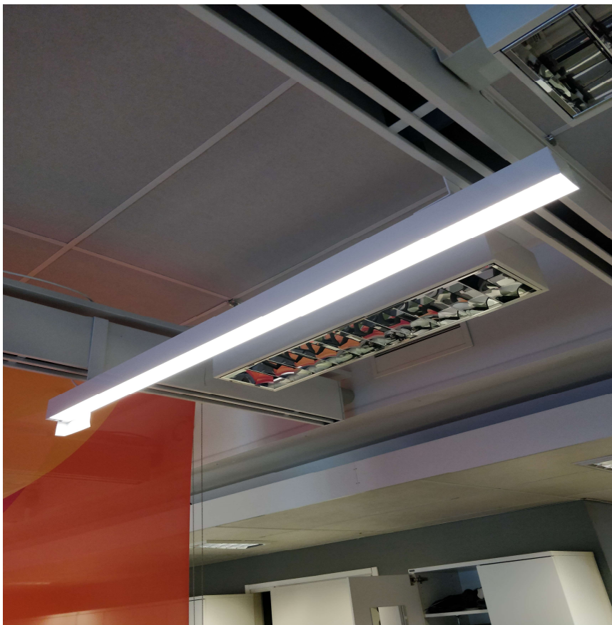
Kuva 23. Elektro-Valon Linear Line-valaisin asennettuna.
