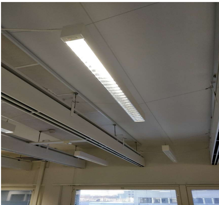
Kuva 39. Kolmannen kerroksen valaisinasennukset.
