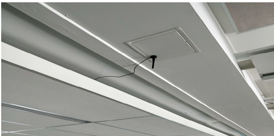
Kuva 57. Bluetooth-antenni kiinnitettynä huoltoluukkuun.
