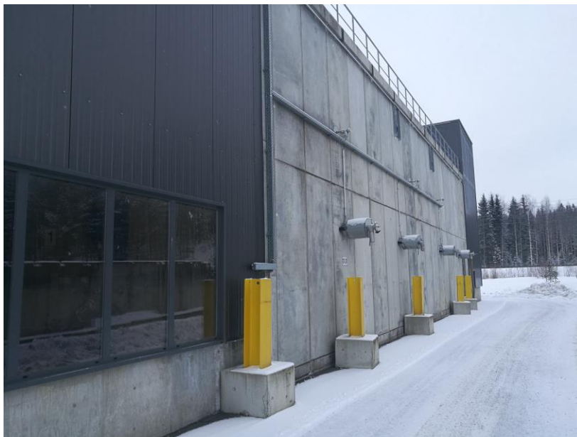
Kuva 16. Biokaasulaitoksen reaktoreiden ulkoseinä
