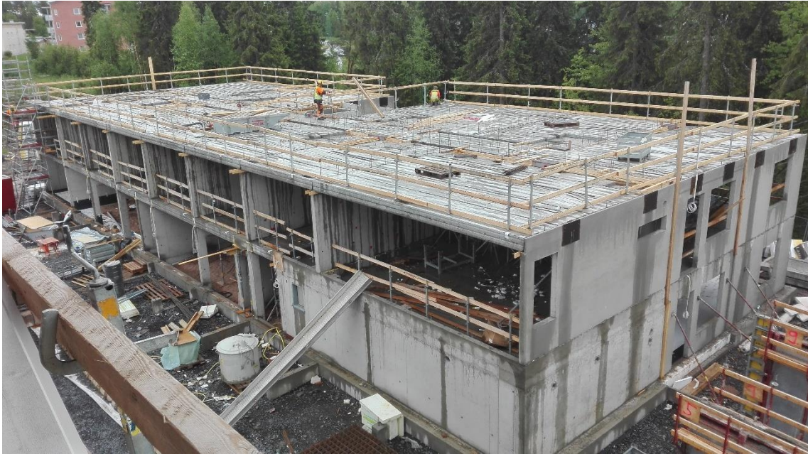
KUVA 4. Turvakaiteiden asennusta.
