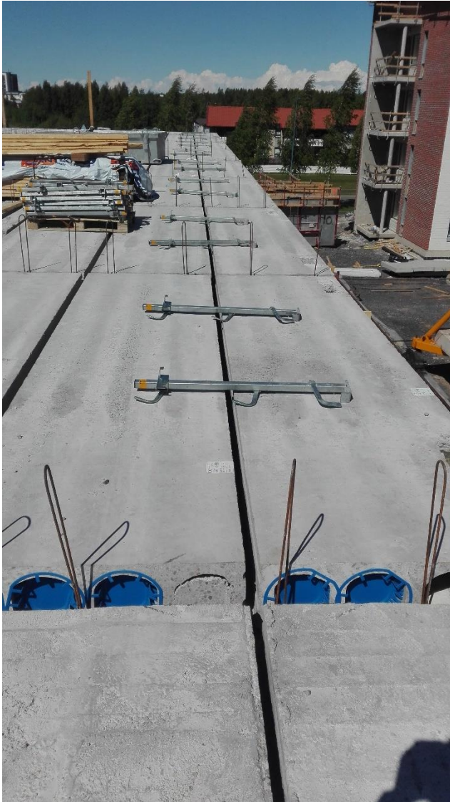
KUVA 3. Pinta-asenteisen turvakaiteen asennus.
