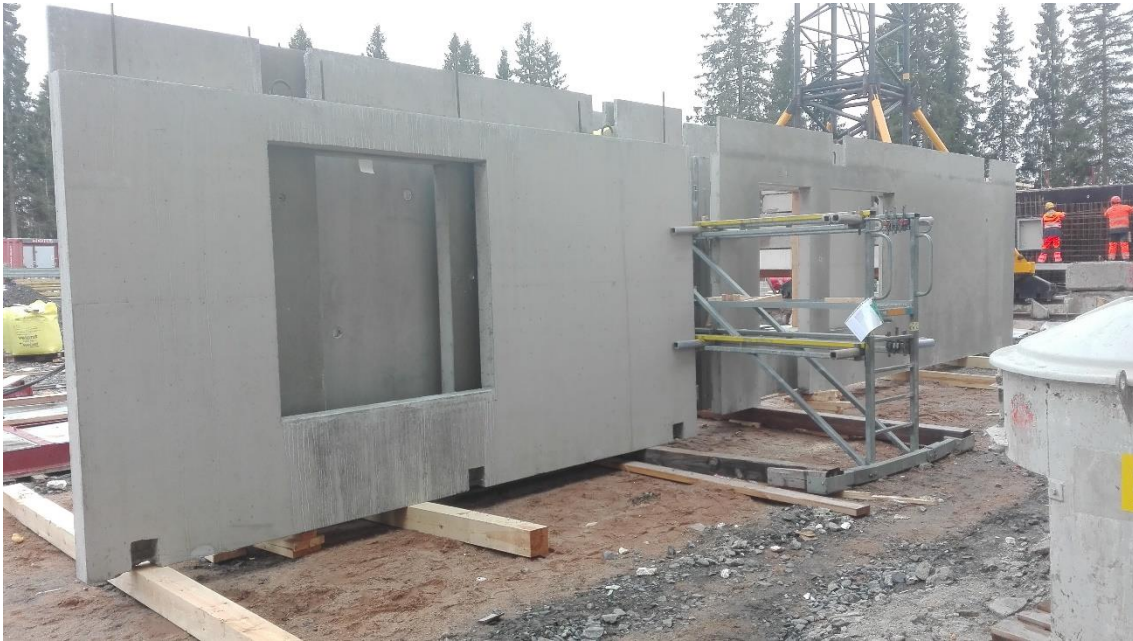
KUVA 1. Elementin väliaikainen säilytys.
