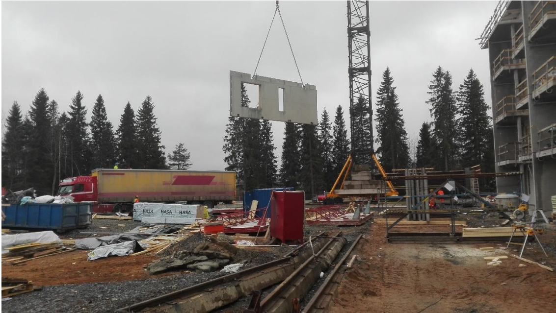
KUVA 2. Betonielementin nosto.
