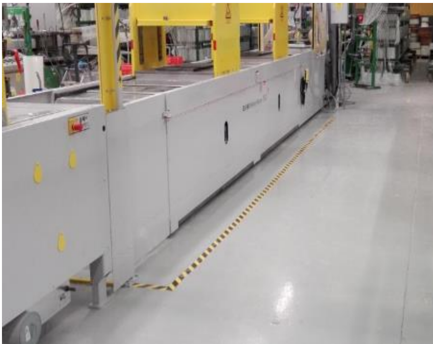
Kuva 52. Tuotantolinjan vasemmanpuoleinen kulkukäytävä toiselta puolelta käytävää, kun paikalta on poistettu kaikki tarpeellinen ja ei-tarpeellinen.
