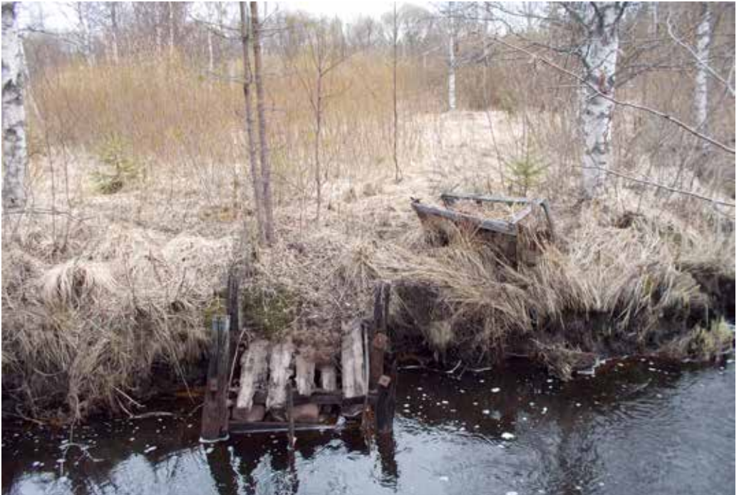
Kuva 122. Vanha laituirakennelma Ukonnurmen itärannalla huhtikuussa 2014.
