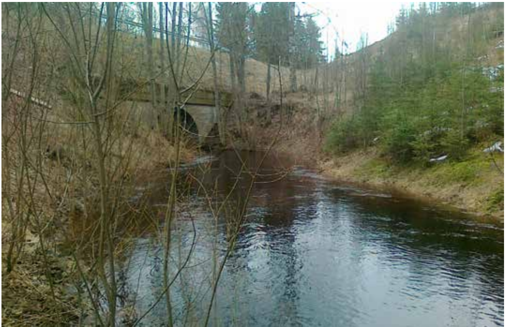
Kuva 70. Jukajoki virtaa Ilomantsintien (kantatie 74) tunneliin huhtikuun lopulla 2013.
