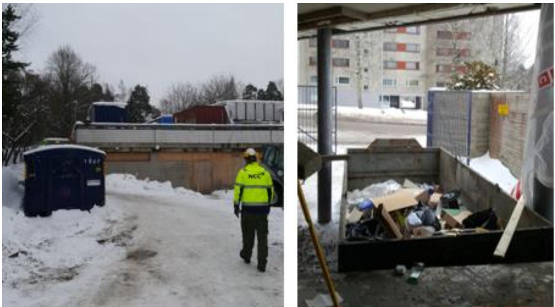
Kuva 15. Rakennusjätelavat, Ankkuri. (Kuvat: Elias Aaltonen)
