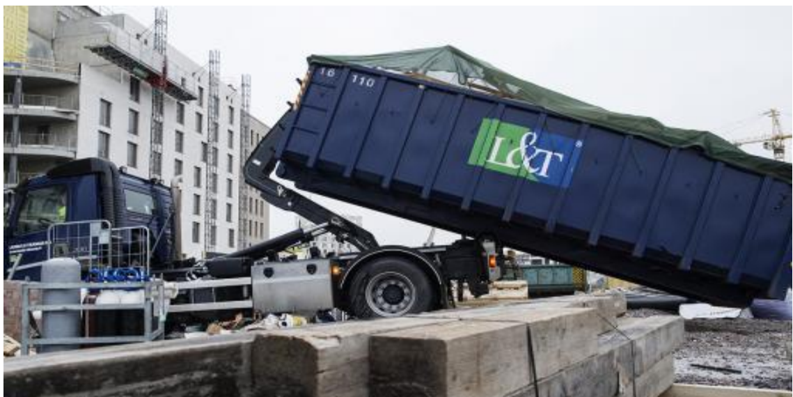
Kuva 6. Jätelavan työmaanouto ( https://www.espressi.com/ )
