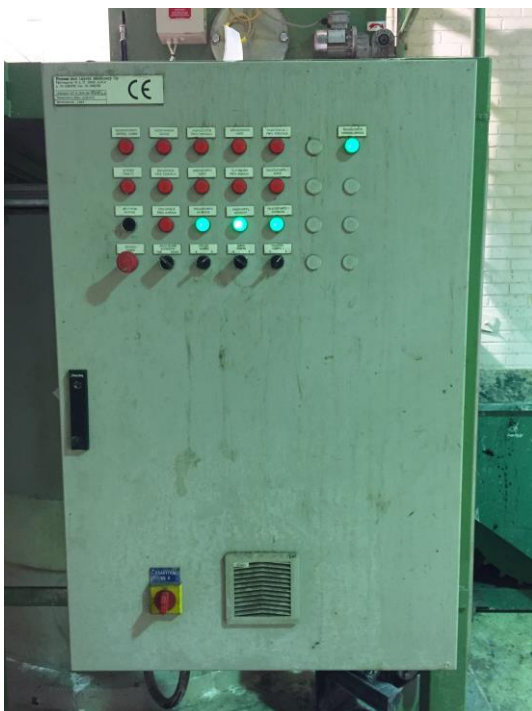
Kuva 9. Hiontaneitejärjestelmän sähkökaappi.
