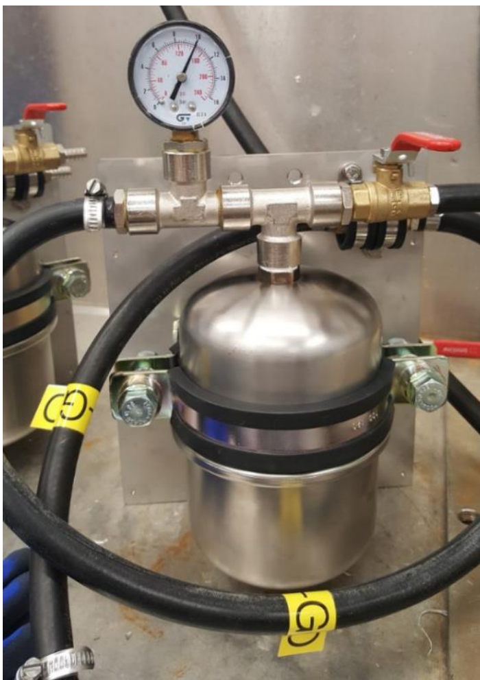
Kuva 36 Sulkunestejärjestelmän koeponnistus 10Bar:lla
