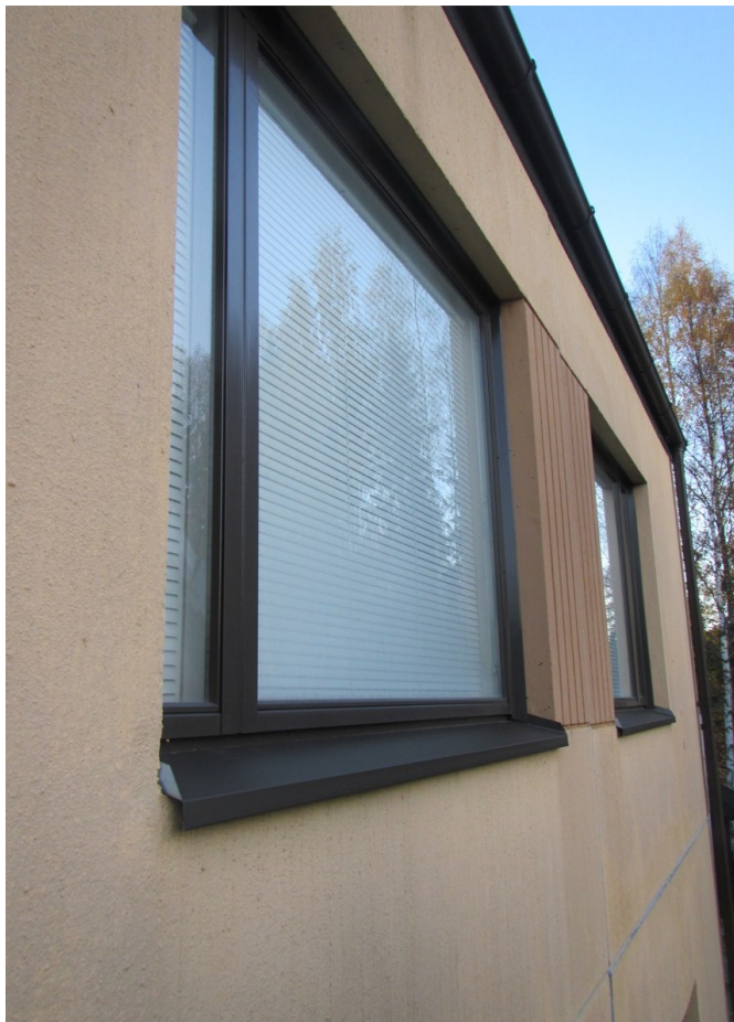
Kuva 34 Yleiskuva kohteen huoneistoikkunasta (B-ikkunamalli)
