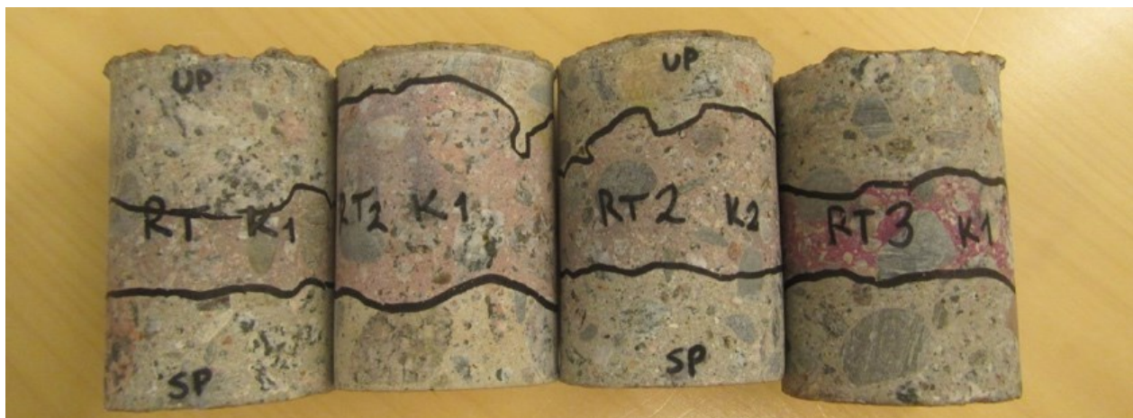
Kuva 28. Parvekekaiteista irrotetut betoninäytteet
