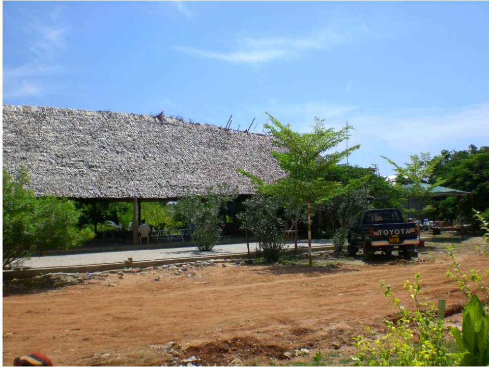
Kuva 91. Bambukatos ja uusi laatoitettu piha-alue. Alueelle tehtiin myös maisemointia, joka paransi alueen viihtyvyyttä.
