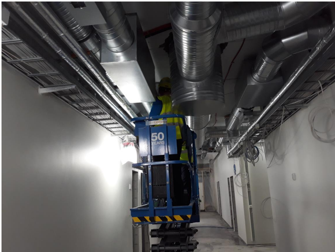
Kuva 22. Rakennusaikainen siivous ennen alas lasketun katon asennusta.
