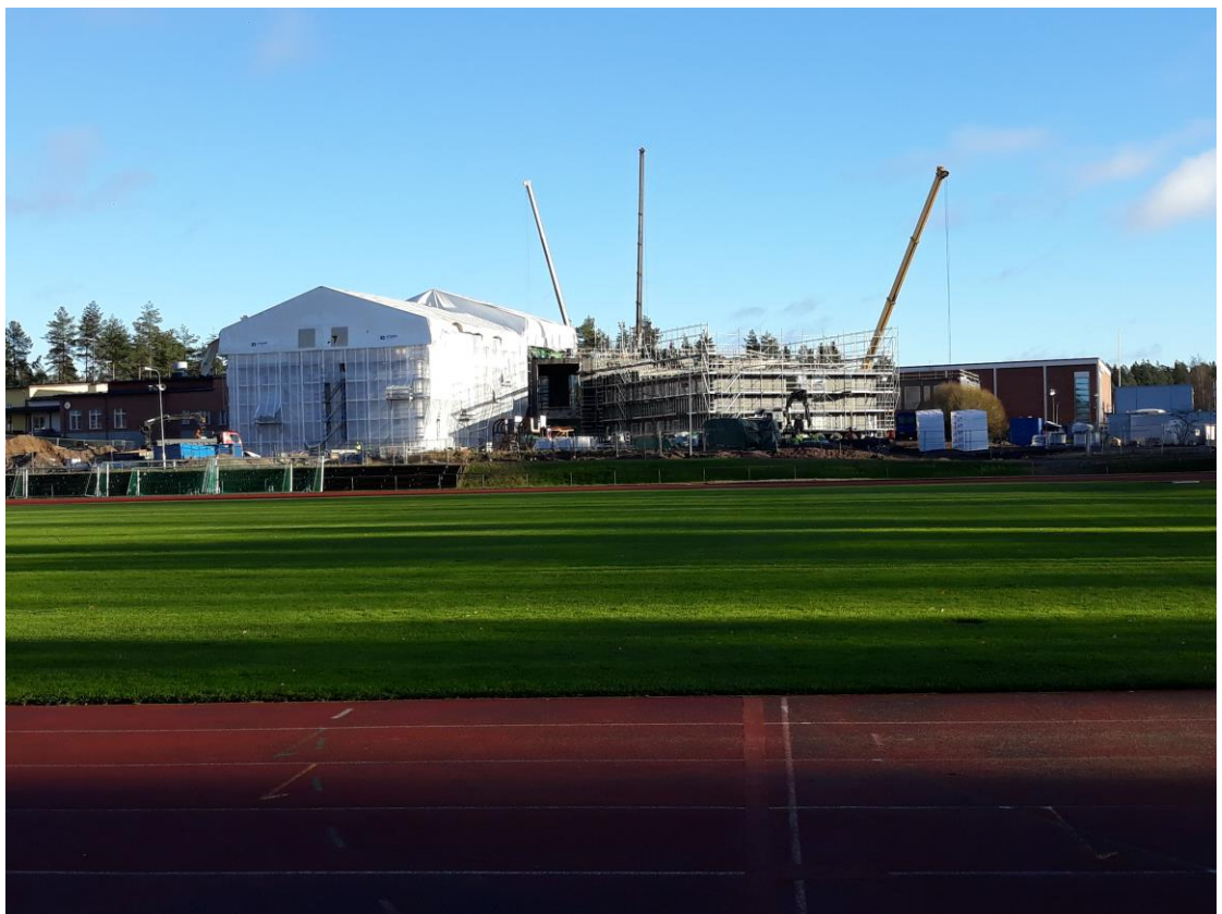
Kuva 12. Sääsuoja lohkoon yksi asennettu ja lohkon kaksi sääsuojan sivuteliineet asennettu.
