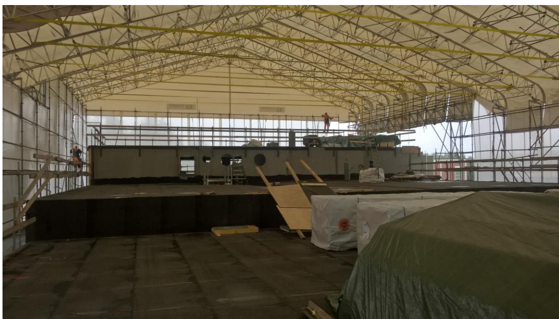
Kuva 15. Valmis sääsuoja ja vesikaton rakennusmateriaaleja suojan sisällä.
