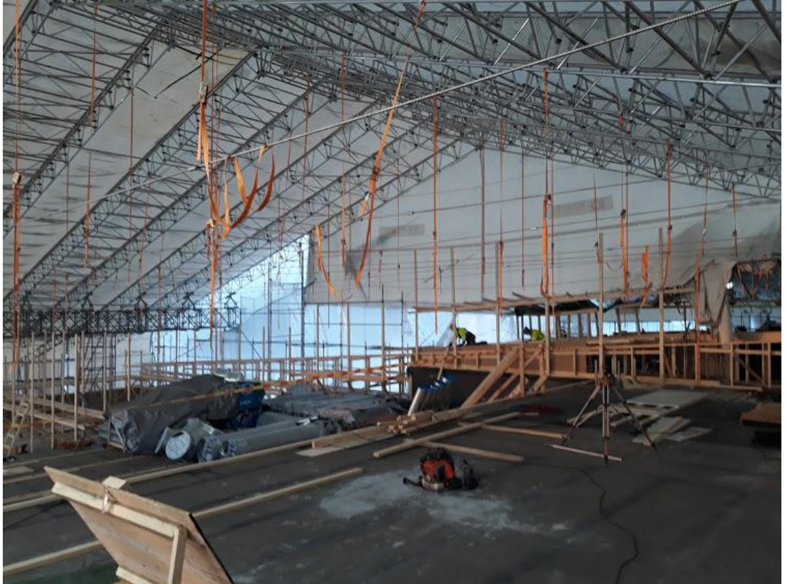
Kuva 16. Vesikattorakenteiden rakentamista sääsuojassa.
