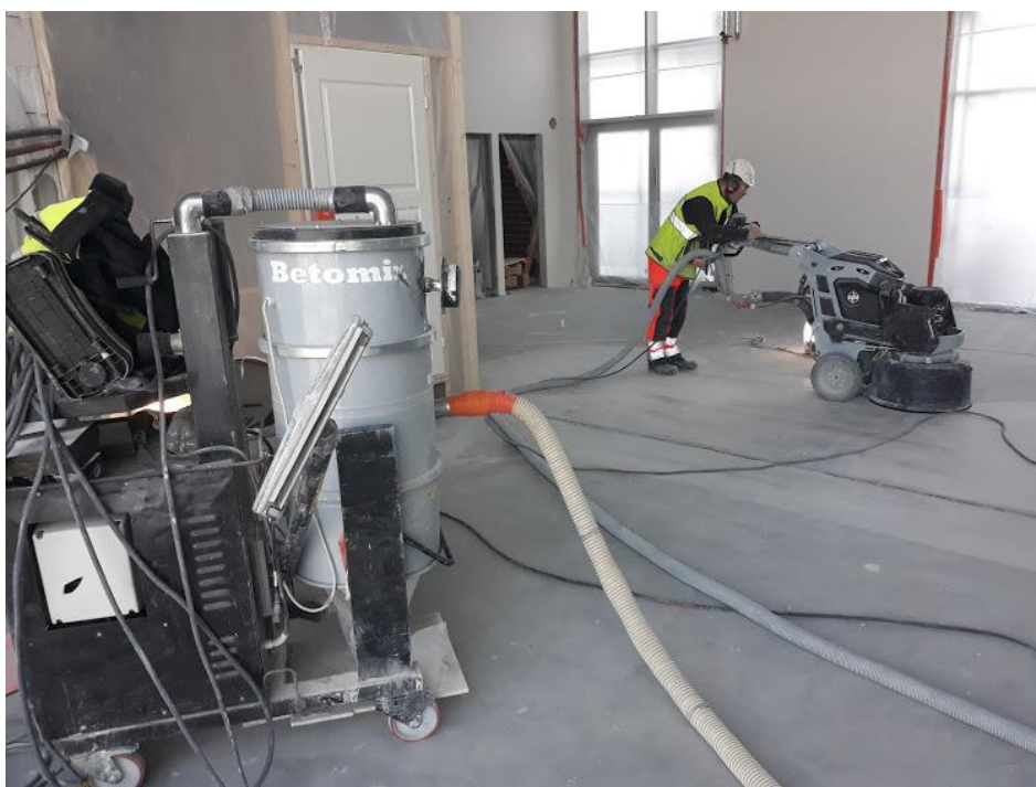
Kuva 24. Lattian hionta pölyämättömällä menetelmällä.
