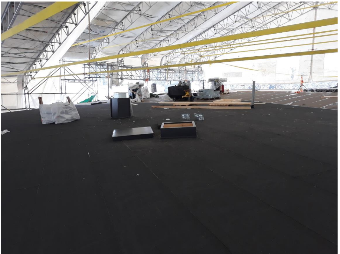
Kuva 17. Huopakaton asennus sääsuojassa talvella.
