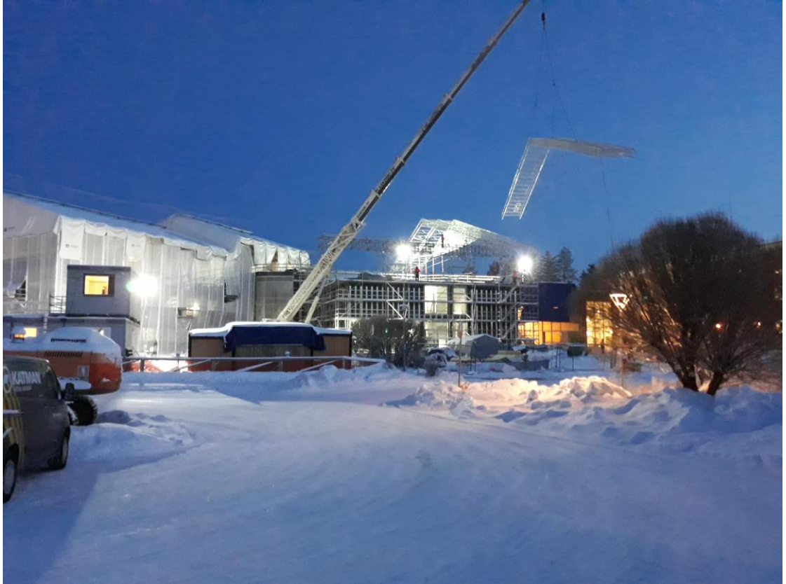
Kuva 13. Sääsuojan asennus lohkolle kolme, lohkon kaksi sääsuoja on paikoillaan.
