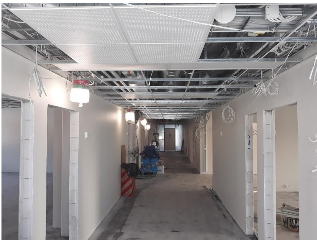
Kuva 25. Alakaton runko on asennettu ja yläpuolinen tila puhtaaksi todennettu.
