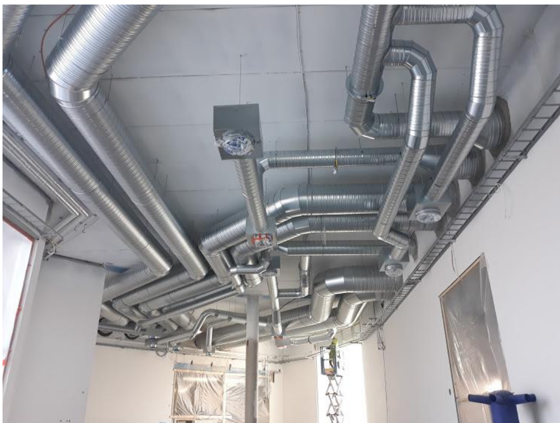
Kuva 19. Alakaton yläpuolisen tekniikan asennusta.
