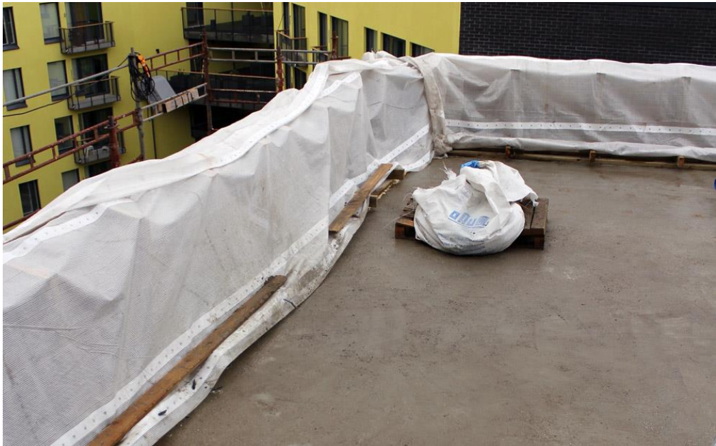
Kuva 6. Betoniseinän suojaaminen muovilla rakennusvaiheessa. Kuva: Mittaviiva Oy 2018.
