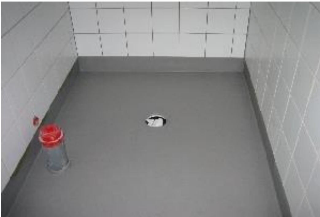
Kuva 20. Kylpyhuone-esimerkki. Seinällä laatoitus ja lattiassa matto, mikä nostettu seinälle. Kuva: Martti Lukander 2010.
