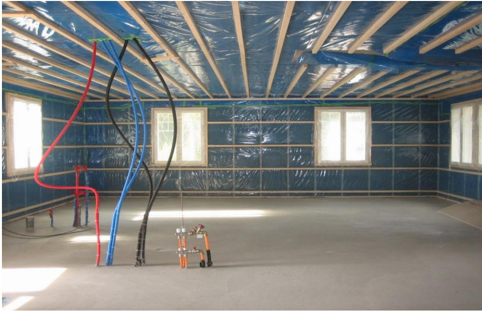
Kuva 15. Höyrinsulkumuovi asennettuna. Kuva: Talotuote 2018.
