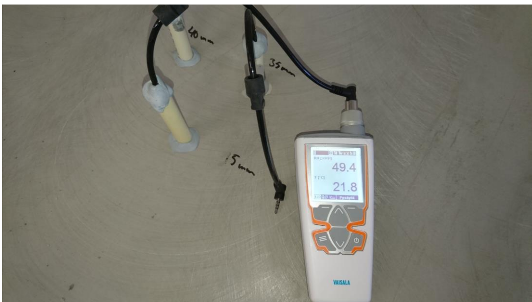
Kuva 10. Porareikämittauslaitteet. Kuva: Kosteusmittaus 2018.
