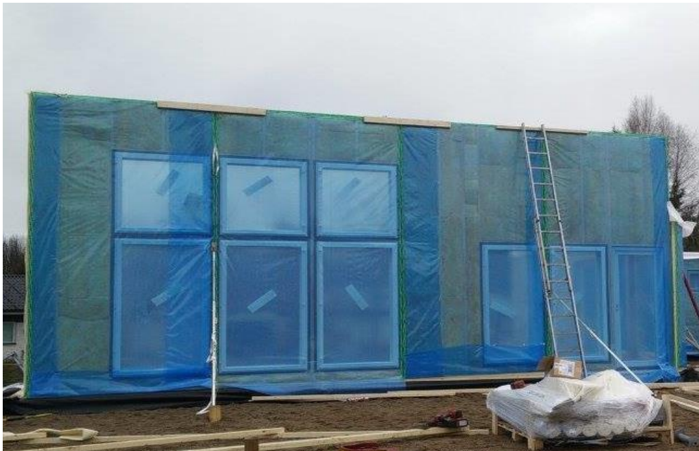
Kuva 5. Puuseinäelementti suojattu muovilla asennusvaiheessa. Kuva: Unelmaa rakentamassa 2016.
