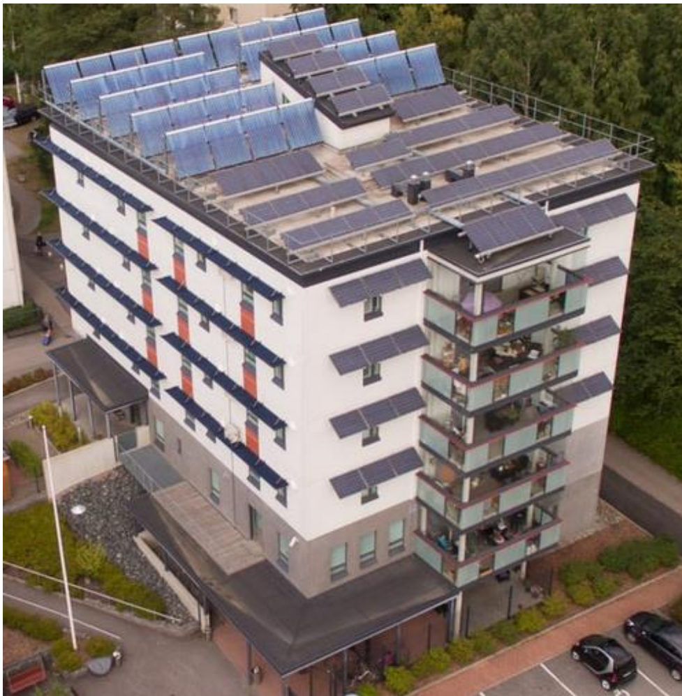
KUVA 4. Ikkunoiden yläpuoliseen aurinkosuojaukseen integroidut aurinkopaneelit Järvenpään nollaenergiatalossa (Kuva: Kivioja 2017)
