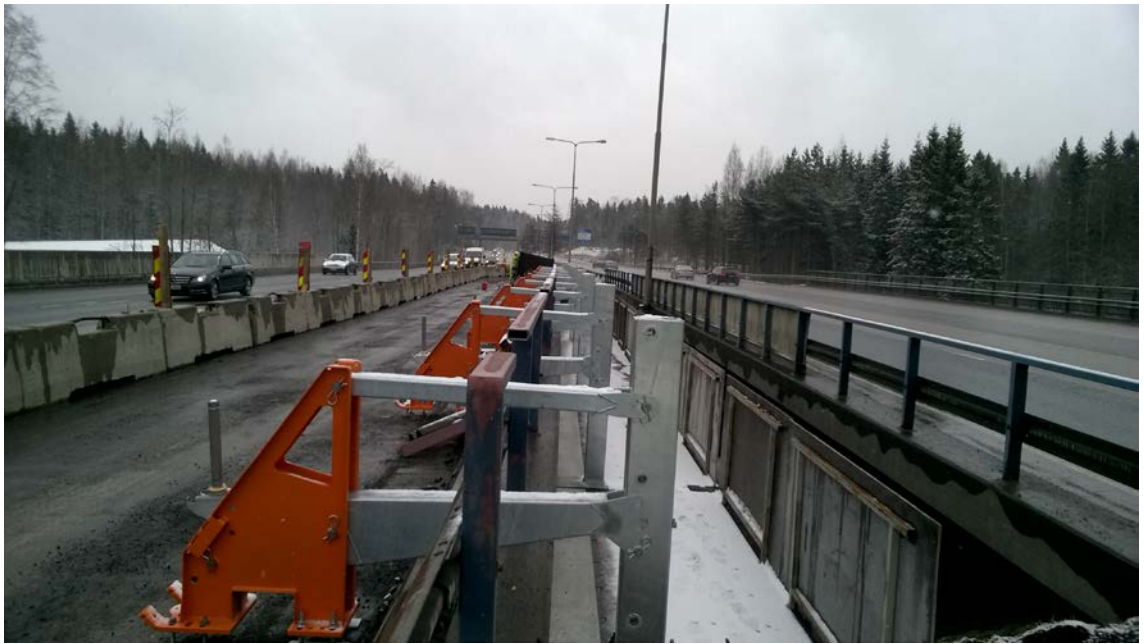
KUVA 6. Fast Beam -teline asennettuna ennen vanhan siltakaiteen lopullista purkamista (Kuva: Timo Laitinen 2016)
