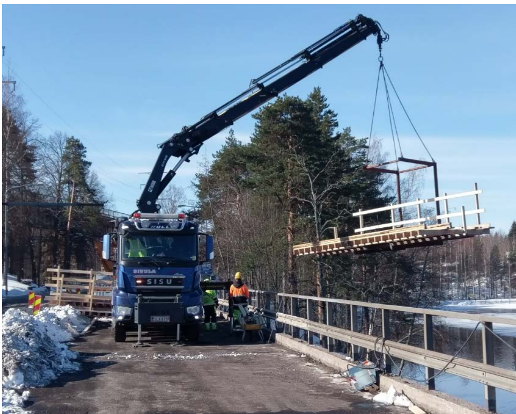
KUVA 4. Roikotettavan telineen asennusta Heinolassa (Kuva: Ville Lonka 2018)
