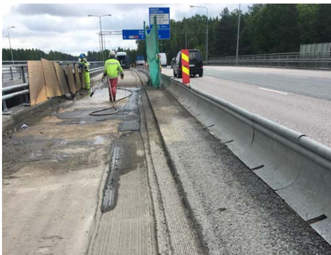
KUVA 3. Mini-Guard aitaa Kehä I -työmaalla kesällä 2017 (Kuva: Sampo Eskola 2017)
