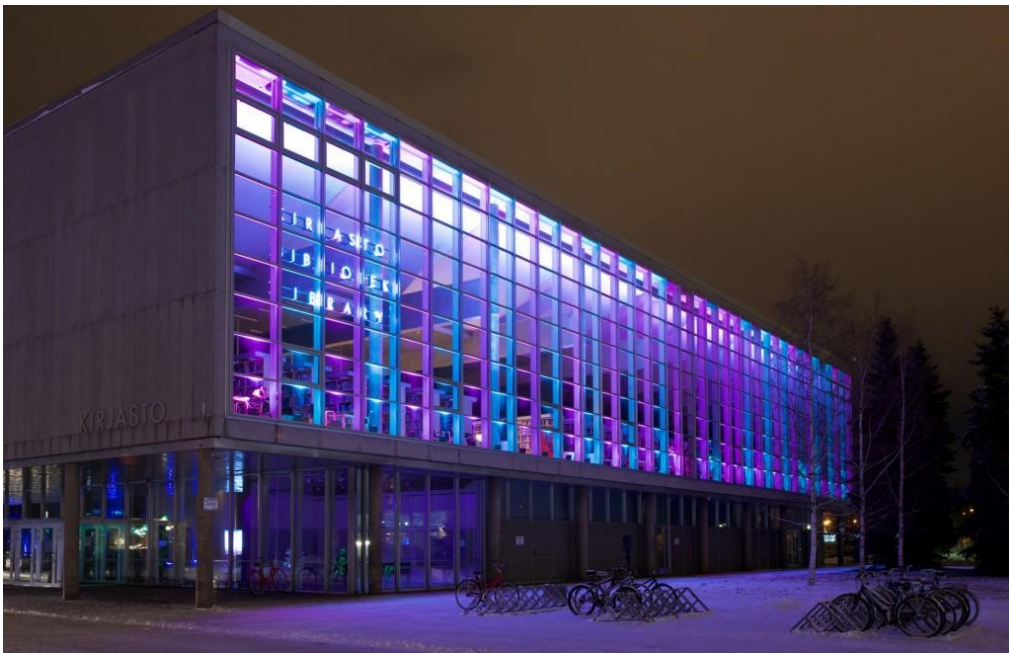
KUVA 1. Lujateko Oy:n valmistama lasiseinä Oulun pääkirjastossa (1)
