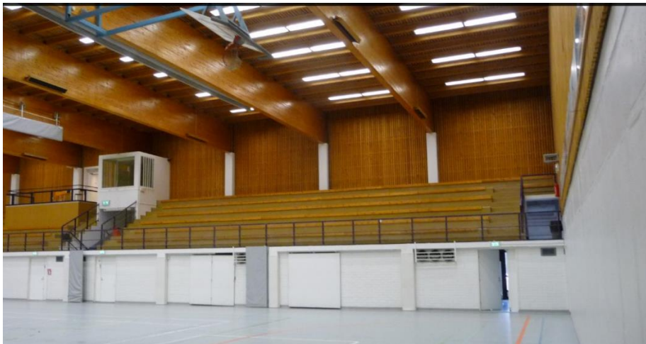
Kuva 5. Tervahallin liikuntasalin nykyvalaistus
