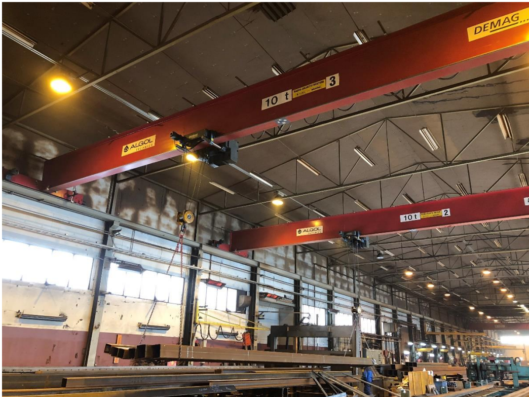
Kuvio 8. Putkien nosto sahalle kahdella siltanosturilla.
