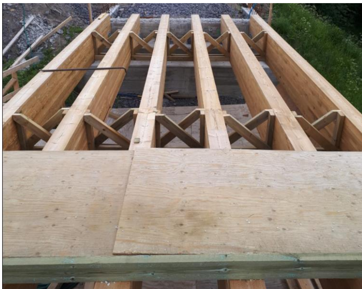
KUVA 2. Palkkien jäykisteet. (Levy Jaani)
