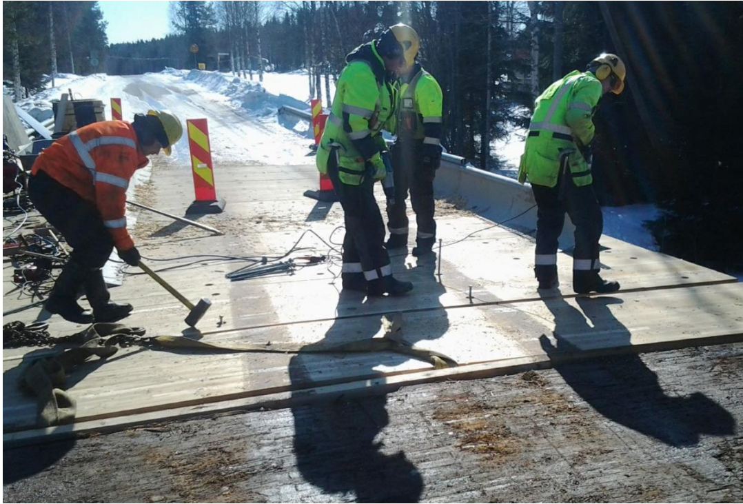
KUVA 9. Elementtien asennus (Härmä Jarmo)
