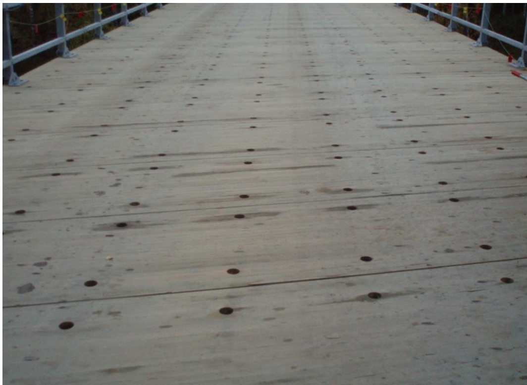
KUVA 10. Elementtikansi asennuksen jälkeen (Voutilainen Juhani)
