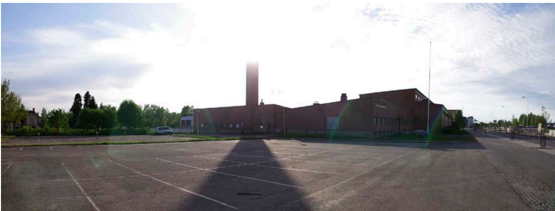
KUVA 17. Varikon päärakennuksen eteläpääty ja parkkipaikka
