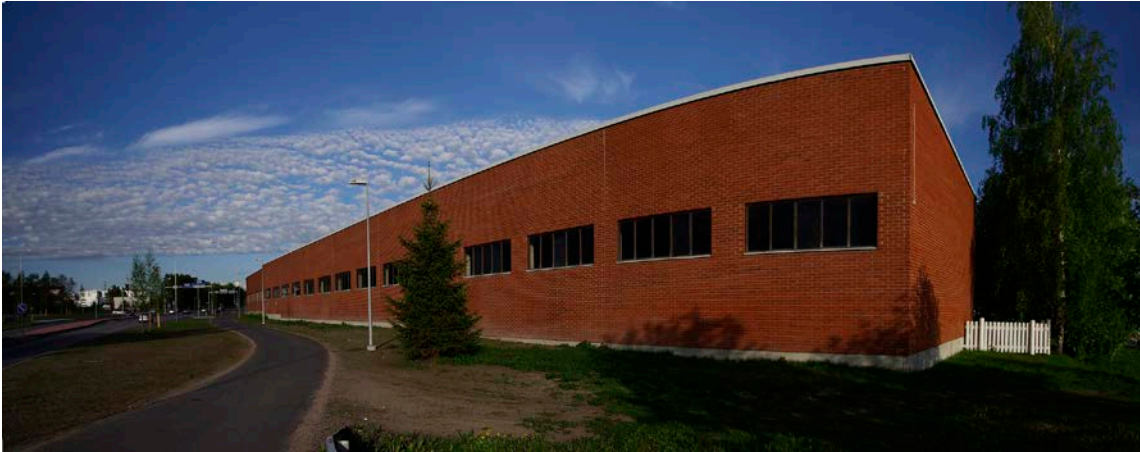
KUVA 15. Varikon kaarihallin 80-luvulla rakennettu laajennus kuvattuna Hietasaarentieltä.
