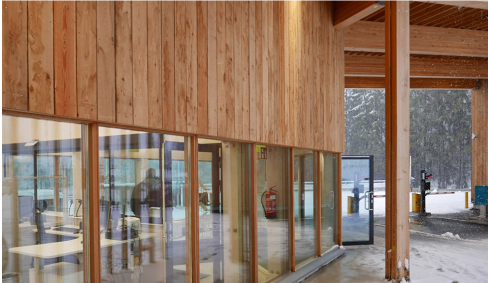
KUVA 15. Lehtikuusipaneelista valmistettu julkisivu (Kirkkonummelle valmistui ensimmäinen julkinen massiivipuurakennus – ulkoseinät lähes ikuista lehtikuusta. 2017)
