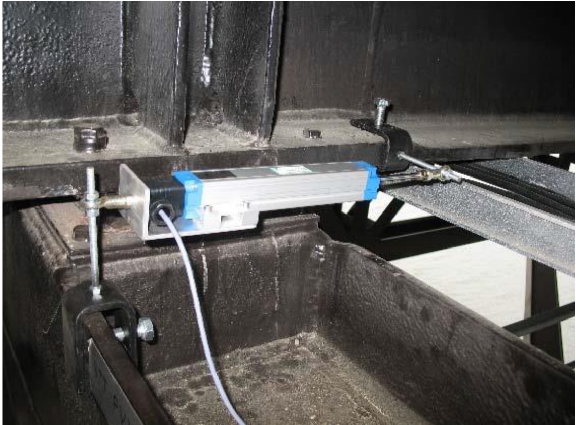
KUVA 3. Mekaaninen liikeanturi asennettuna sillan kannen ja pääristikoiden väliin (Liikennevirasto 2016)
