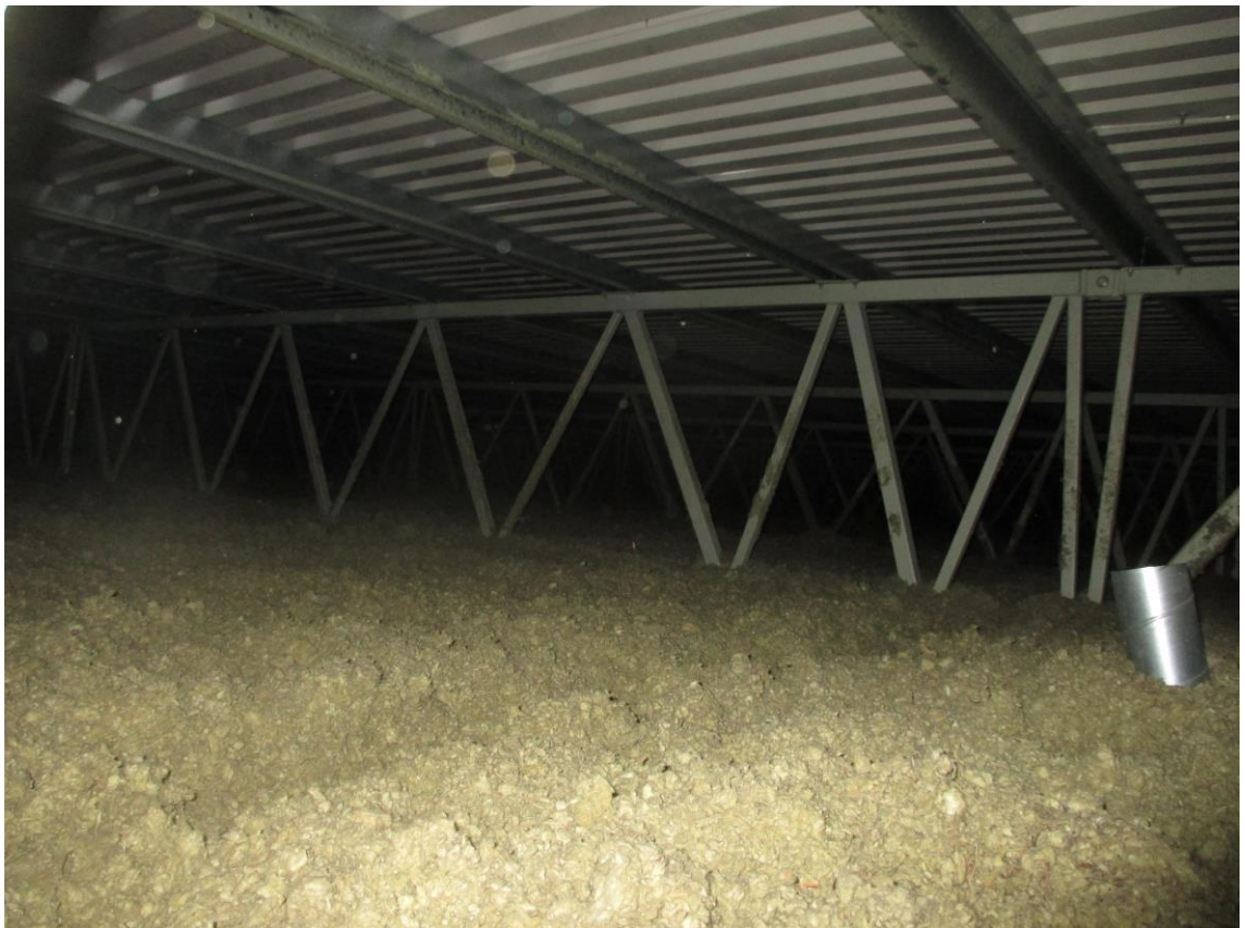
KUVA 22. Jäähallin välikattotila (A-Insinöörit Suunnittelu Oy 2017)
