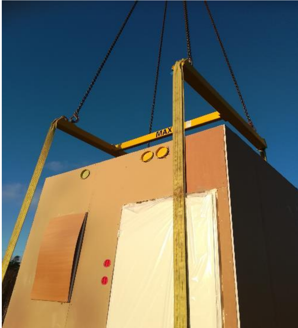
Kuva 7. Tekniikkastudion asennuksessa käytetään nostokehikkoa ja liinoja.
