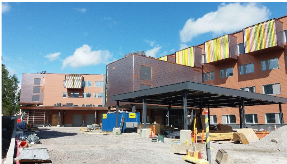
Kuva 21. Järvenpään uuden sosiaali- ja terveyskeskuksen sisäpiha rakentamisvaiheessa heinäkuussa 2016.
