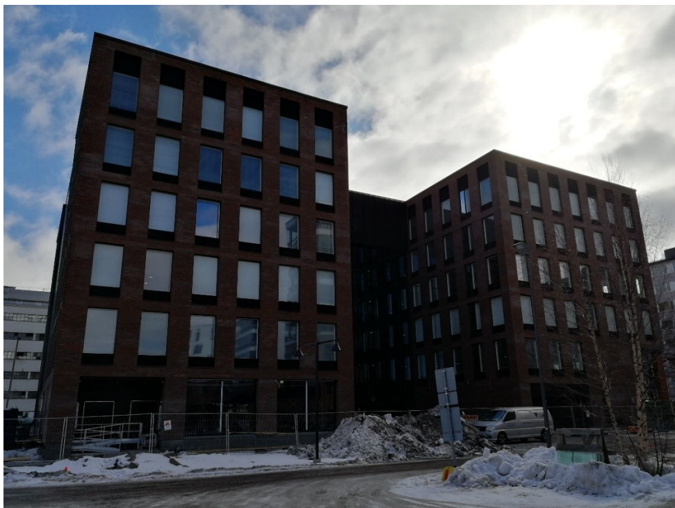
Kuva 17. Fredriksberg A:n työmaa maaliskuun lopussa 2018. Rakennuksessa oli käynnissä viimeistelytyöt.
