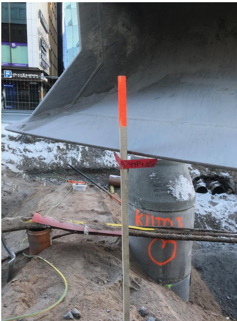
Kuva 16. Kaivinkone ottaa korkotiedot mittamiehen asettamasta korkokepistä 2D-koneohjausjärjestelmään. (Aleksi Mäntyharju 2018)
