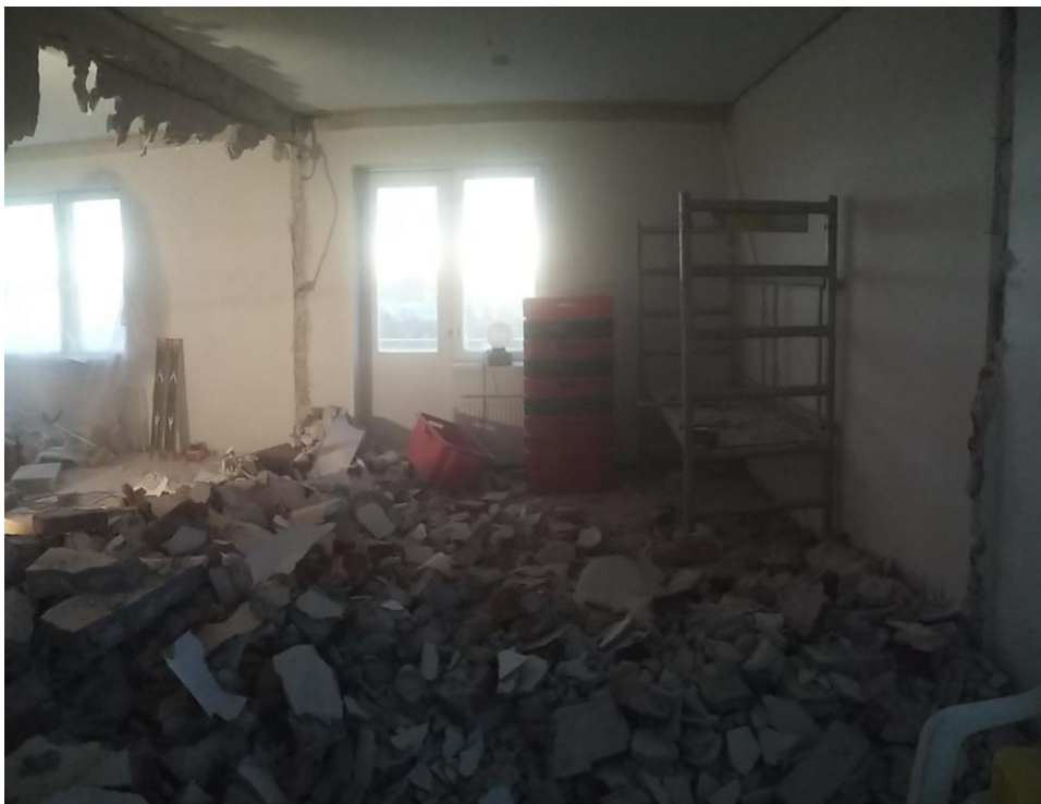
Kuva 4. Väliseinien purkaminen
