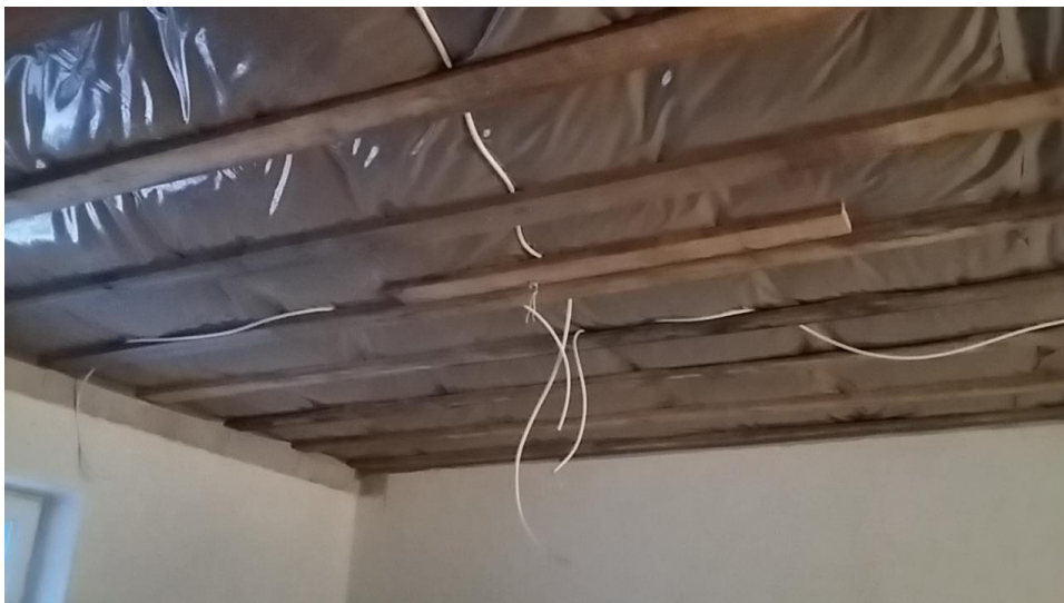
Kuva 5. Putketonta kaapelin asennusta katon pintaverhouksen yläpuolelle
