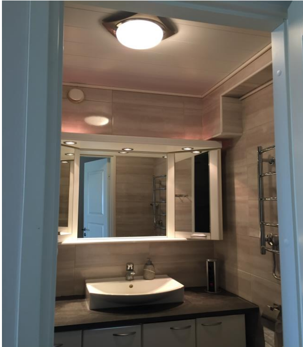
Kuva 12. WC:n valaistus ja Airamin tasoon upotettava pylväspistorasia
