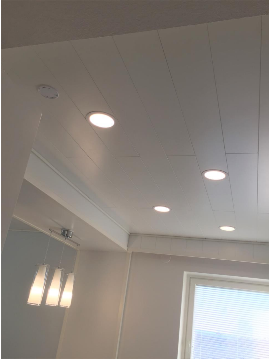
Kuva 14. Keittiöön upotettiin led-valaisimet sekä koristeelliseen valemalkkiin tehtiin valaisinpiste. Riippuvan valaisimen alle sijoitetaan ruokailupöytä.
