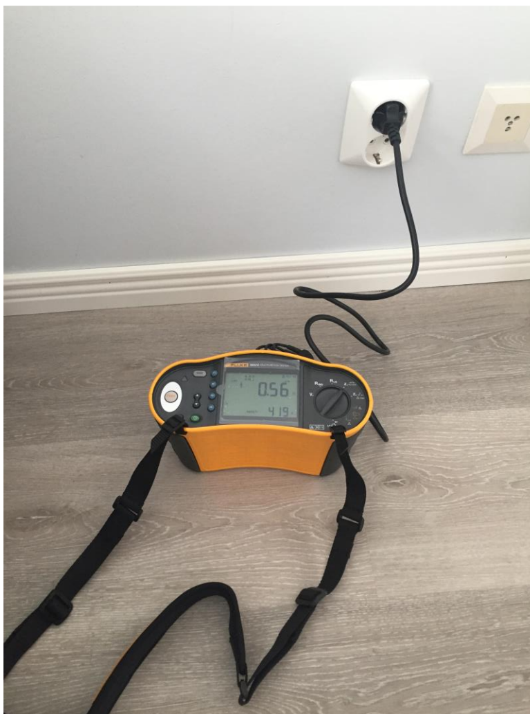
Kuva 11. Syötön automaattisen poiskytkennän toiminnan testaus
