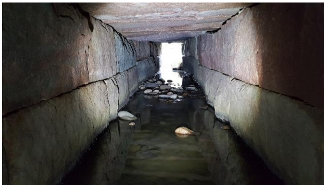
KUVA 2. Kivirumpu, jota jatkettu betoniputkirummulla. (Sitowise 2016)
