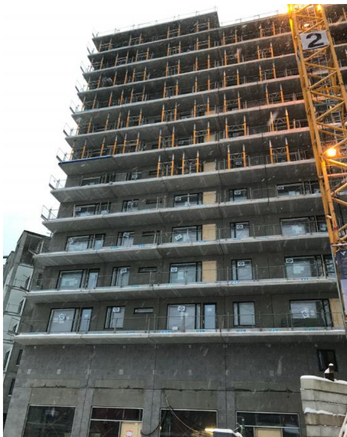
Kuva 23. Tukitornit poistettu alhaaltapäin. [17.]
