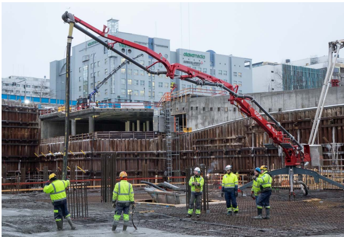
Kuva 3. Holvivalu mobiilipumppua ja siirrettävää jakelupuomia käyttäen (Takkinen 2017).
