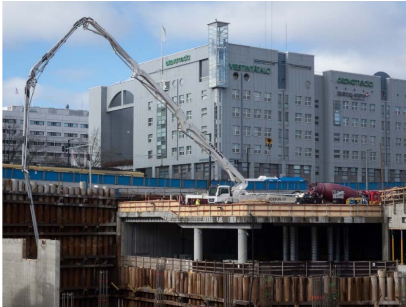
Kuva 1. Betonivalu mobiilikalustolla, kuvassa Cifan 60-metrinen mobiilipumppu (Takkinen 2016).
